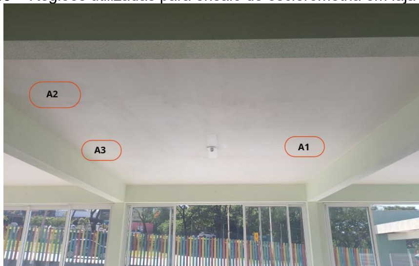
Figura 43 – Regiões utilizadas para ensaio de esclerometria em laja estudada
