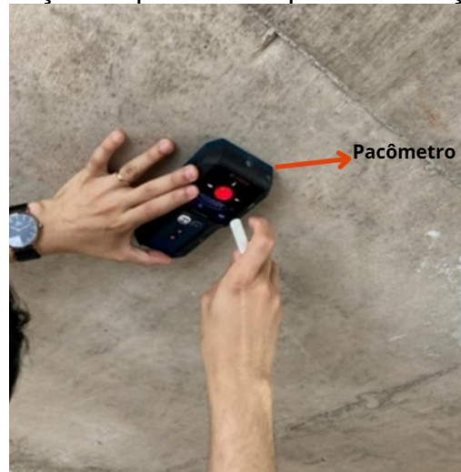
Figura 37 – Aplicação da pacometria para localização de armadura.
