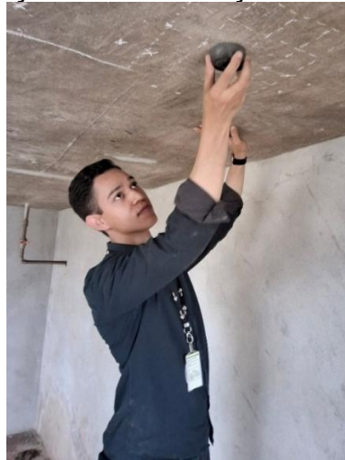
Figura 38 – Realização da escarificação com pedra carborundum
