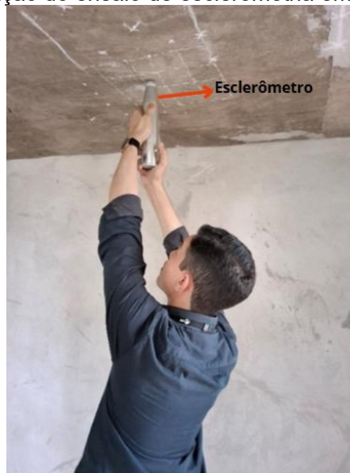
Figura 49 – Aplicação do ensaio de esclerometria em laje de reservatório
