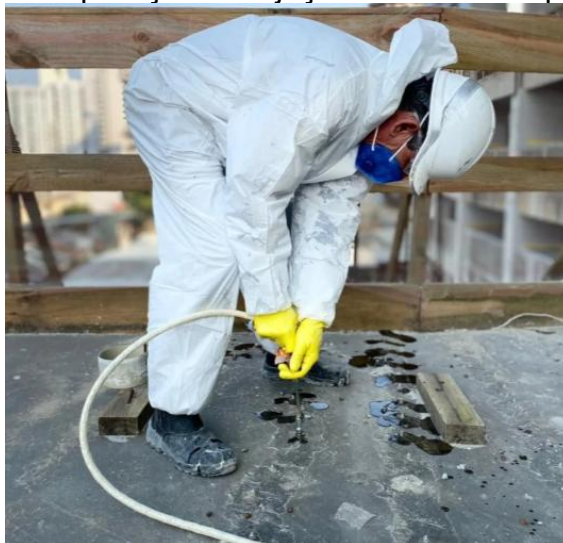
Figura 41 – Aplicação de injeção com resina epóxi
