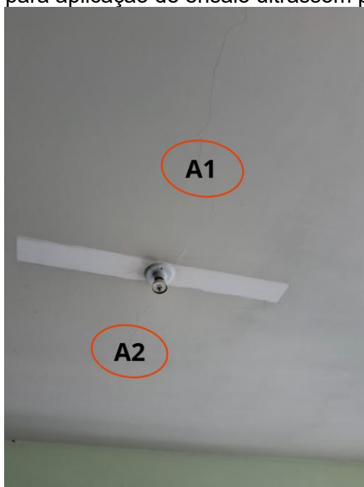
Figura 44 – Regiões para aplicação de ensaio ultrassom para laje de circulação
