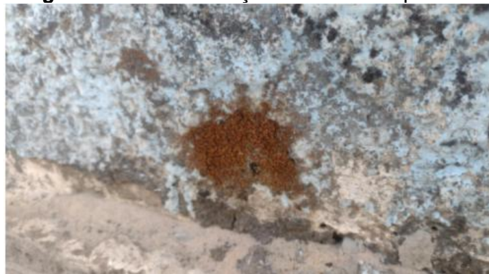
Figura 20 – Manifestação de bolor em parede.
