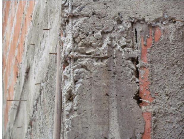
Figura 1– Nicho de concretagem
