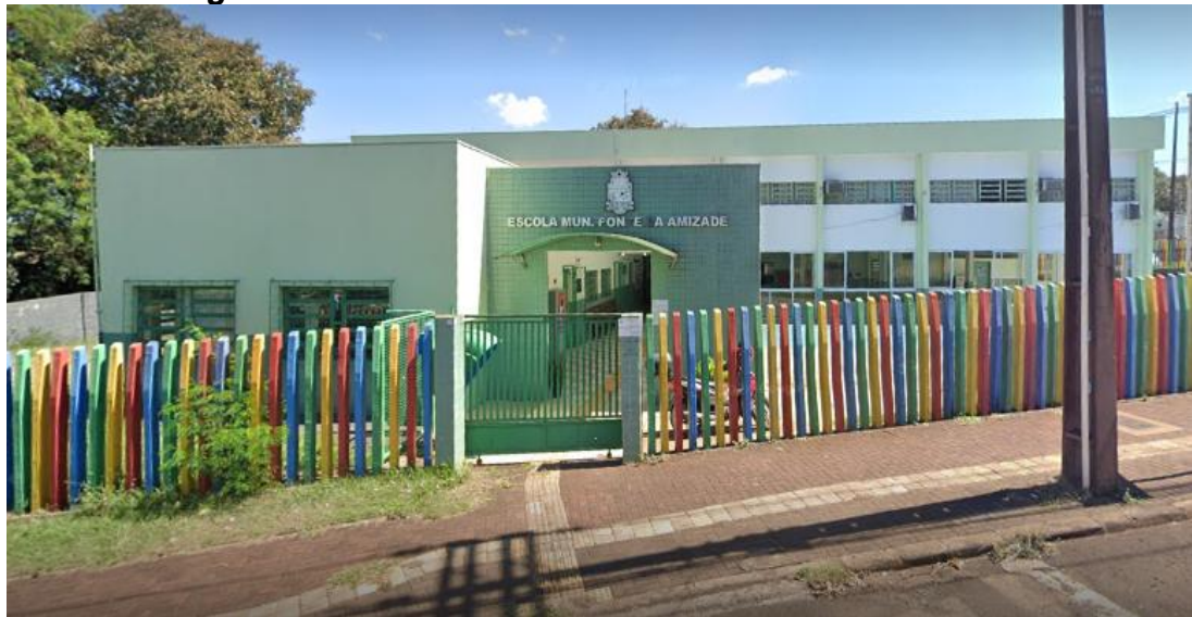
Figura 32 – Vista Frontal da EMEF Ponte da Amizade.
