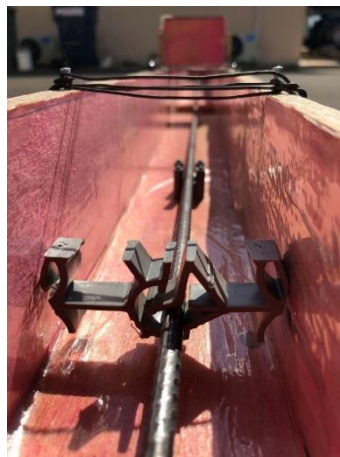
Figura 27 – Seção transversal da fôrma, com detalhe dos espaçadores para posicionamento da armadura, envelopamento da fôrma e do travamento com arame recozido.
