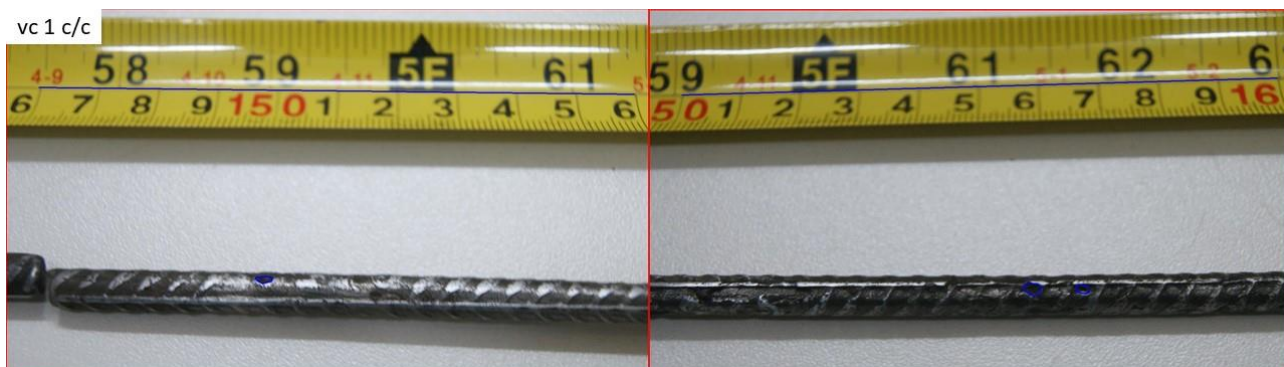
Figura 91 - áreas superficiais corroídas do vergalhão da viga vc 1 c/c – parte 2
