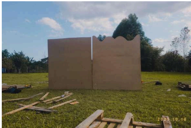
Figura 43: Registro do dia de construção das fachadas na locação.
