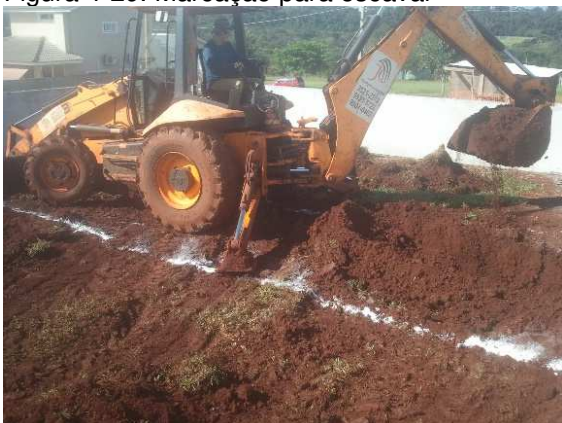
Figura 4-29. Marcação para escavar
