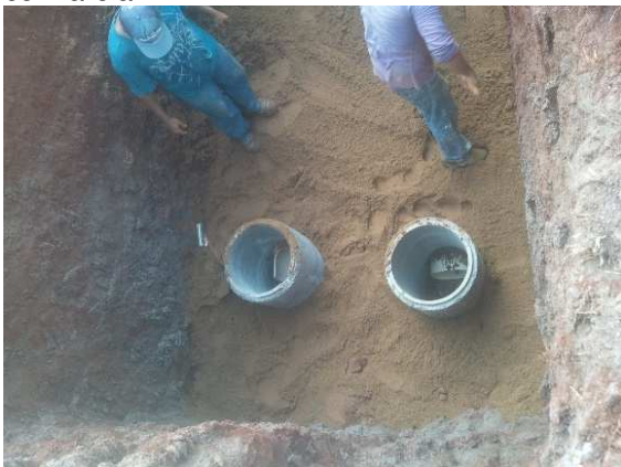
Figura 4-35. Preenchimento total da envoltória com areia
