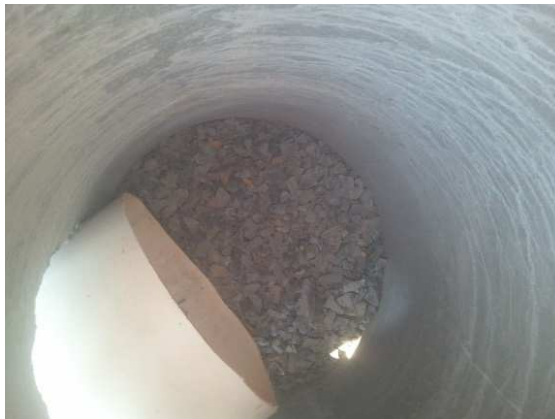
Figura 4-32. Conexão entre tubos de concreto e PVC
