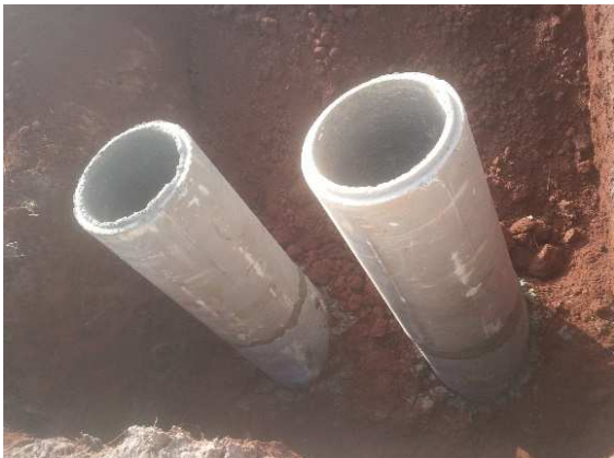
Figura 4-33. Montagem dos tubos de PVC
