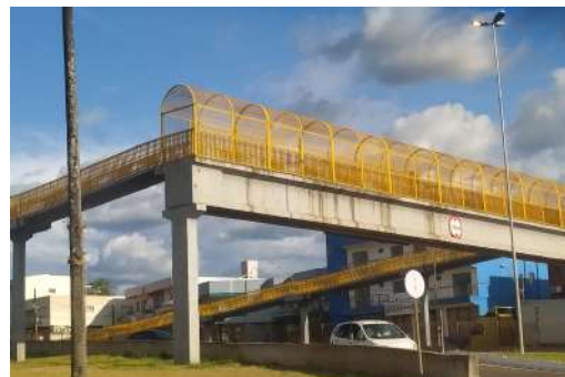
Figura 105 -Passarela de Matelândia. (AUTORA 2022)
