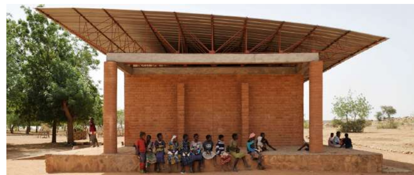
Figura 061 - Cobertura Estrutura Metálica. (ARCHDAILY, 2016).
