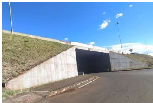
Figura 104 - Viaduto de Matelândia. (AUTORA 2022)
