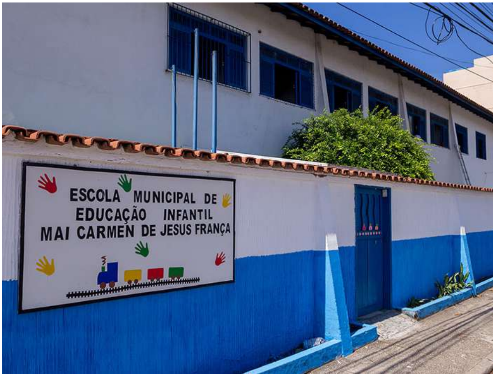
Figura 012 - Muros - Escola Infantil. (SECOM, 2018)
