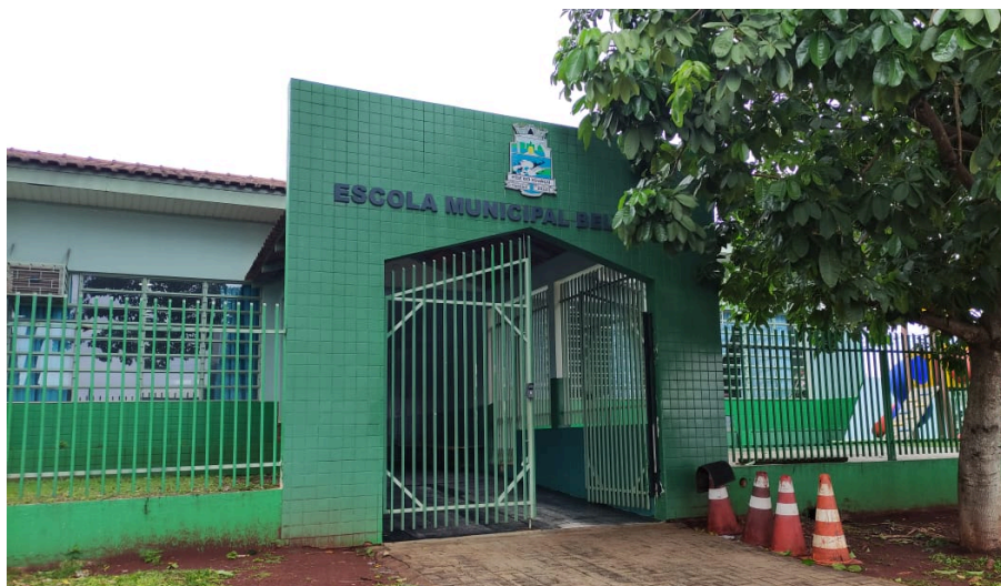
Figura 24- Escola Municipal Belvedere
