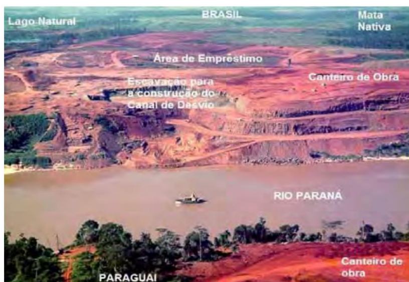
Imagem 7 – Imagem da preparação do canteiro de obras de Itaipu
