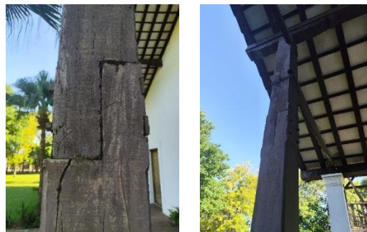
Figura 57. Empalme de los horcones de la fachada.
