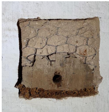
Figura 44. Capas del proceso de revoque Templo San Buenaventura
