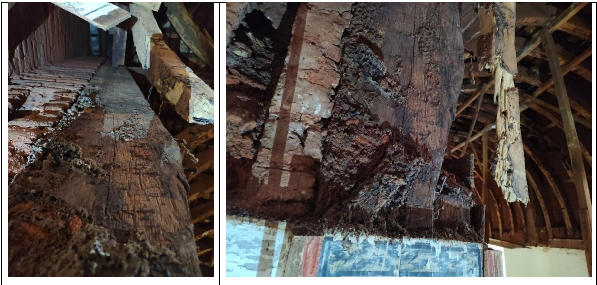
Figura 77. Manifestación patológica con ataque de xilófagos
