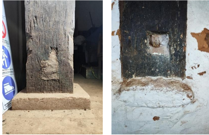
Figura 49. Pilares sin revestimiento del Templo San Buenaventura.
