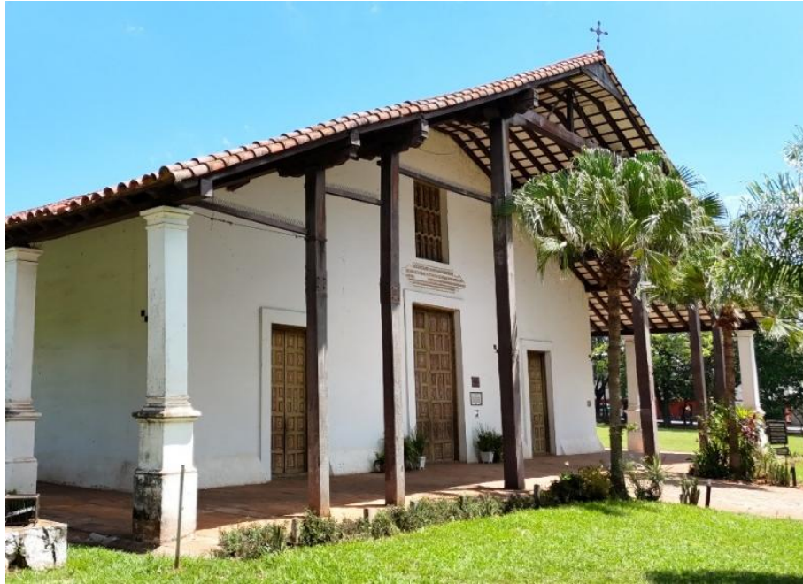
Figura 4. Fachada principal Templo San Buenaventura de Yaguarón
