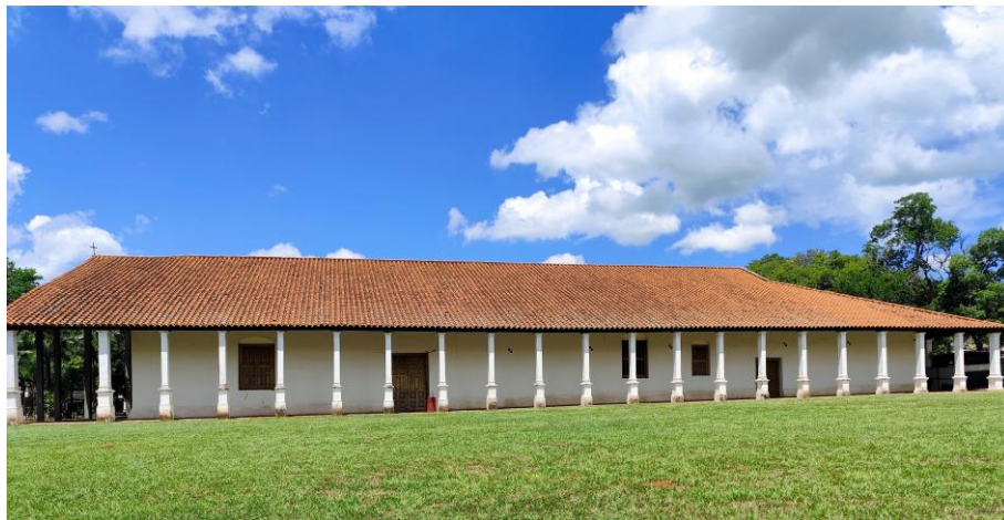
Figura 8. Fachada norte Templo de San Buenaventura
