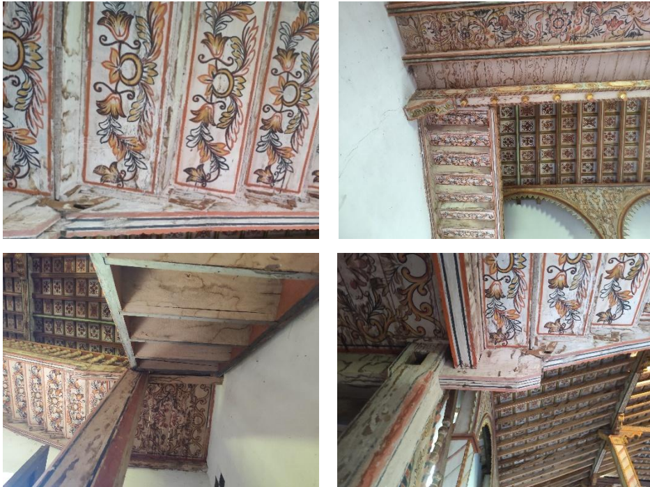
Figura 63 Escalera del coro del Templo San Buenaventura
