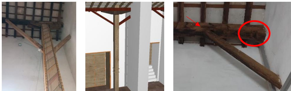
Figura 66. Pilares con soportes diagonales del Templo San Buenaventura.
