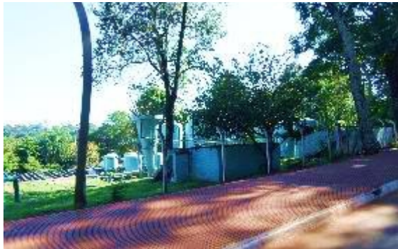
Foto 102: Uso semi público: Planta de tratamiento de agua. Fuente: Autoría propia. 2021
