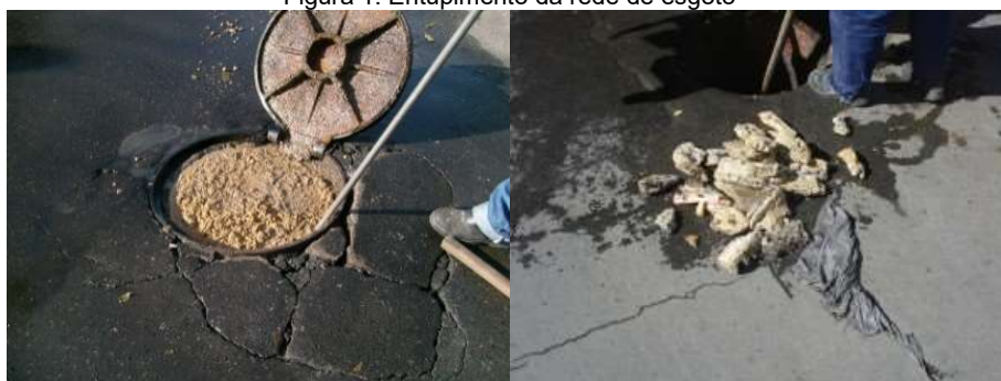
Figura 1: Entupimento da rede de esgoto
