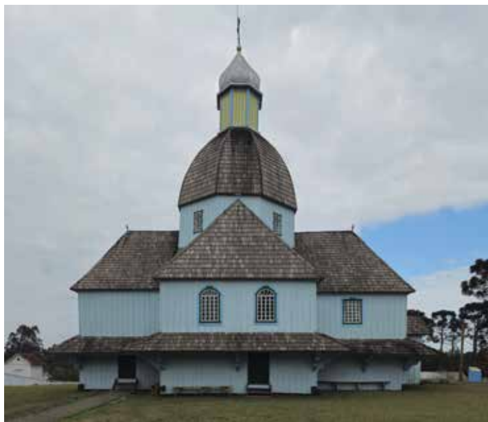
Figura 19: Lateral norte, notam-se as portas laterais e bancos externos. Fonte: o Autor (2025).
