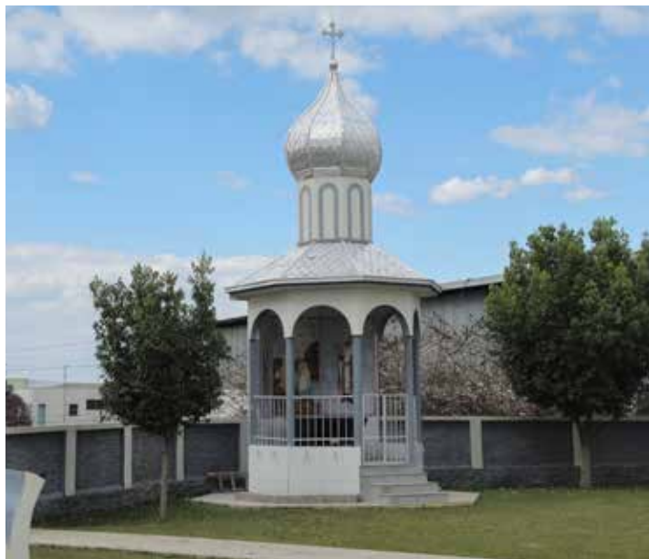
Figura 31: Capela dedicada à São João Batista. Fonte: o Autor (2025).
