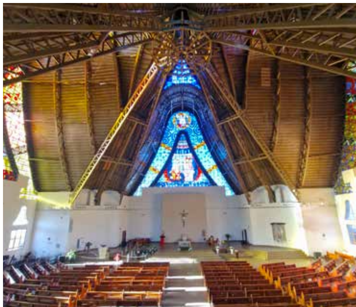
Figura 163: Nave principal. Destacam-se a estrutura do telhado e os vitrais. Fonte: o Autor (2025).
