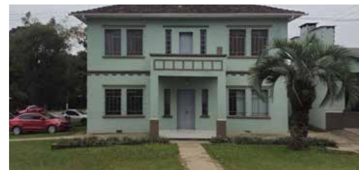
Figura 41: Casa paroquial da Igreja São José - Mallet (PR). Fonte: o Autor (2025).
