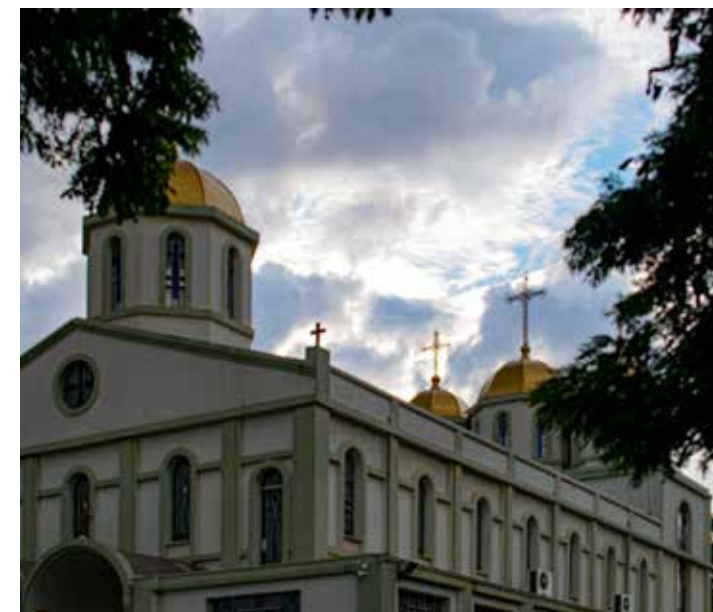
Figura 57: Exterior da Igreja Santíssima Trindade - Campo Mourão (PR). Fonte: o Autor (2025).
