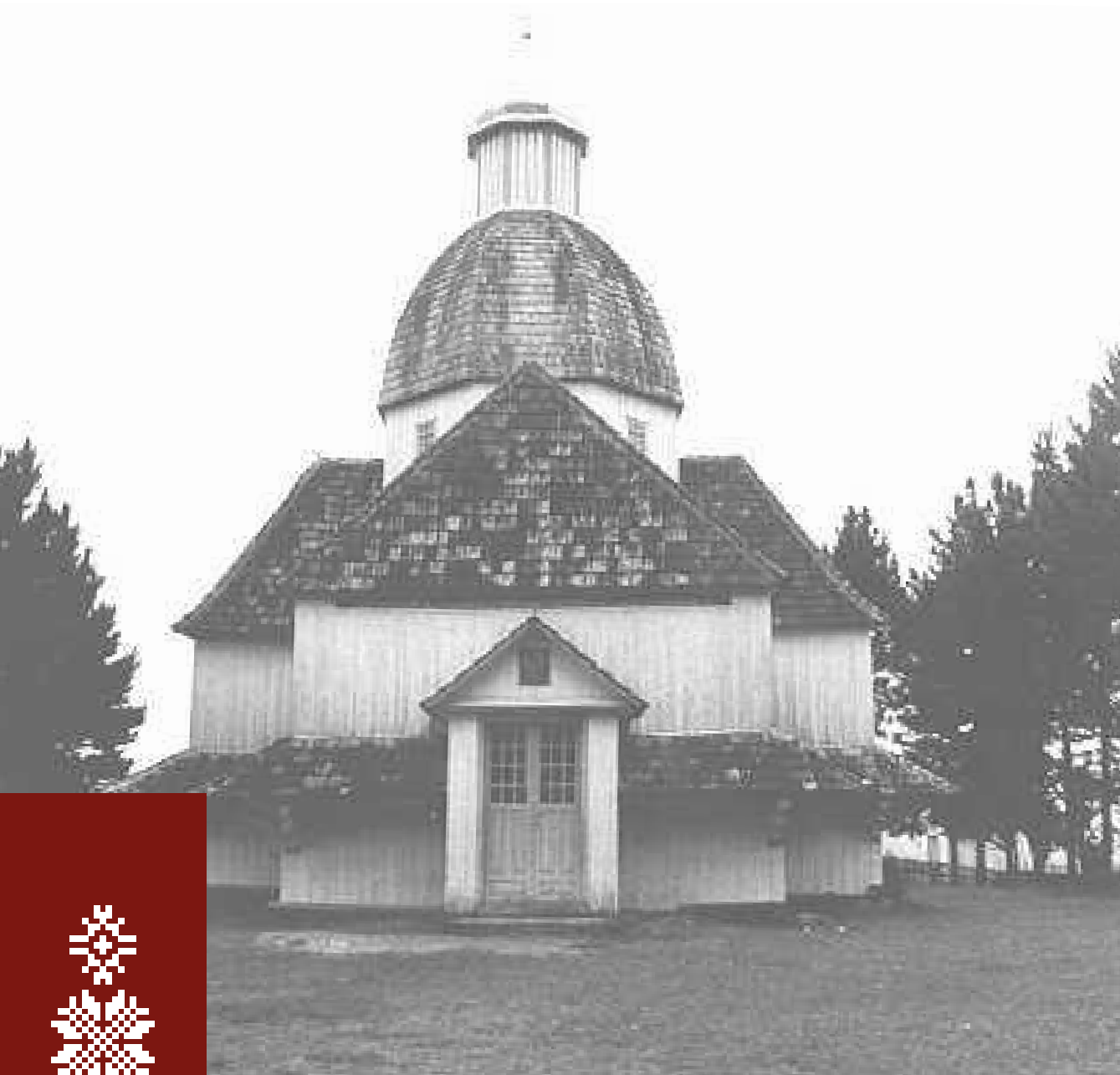
Figura 7: Igreja São Miguel Arcanjo, localizado na Serra do Tigre - Mallet (PR), quando do seu tombamento como Patrimônio Cultural do Estado do Paraná em 1982.
