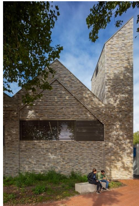
Figura 40- El revestimiento del edificio con piedras.
