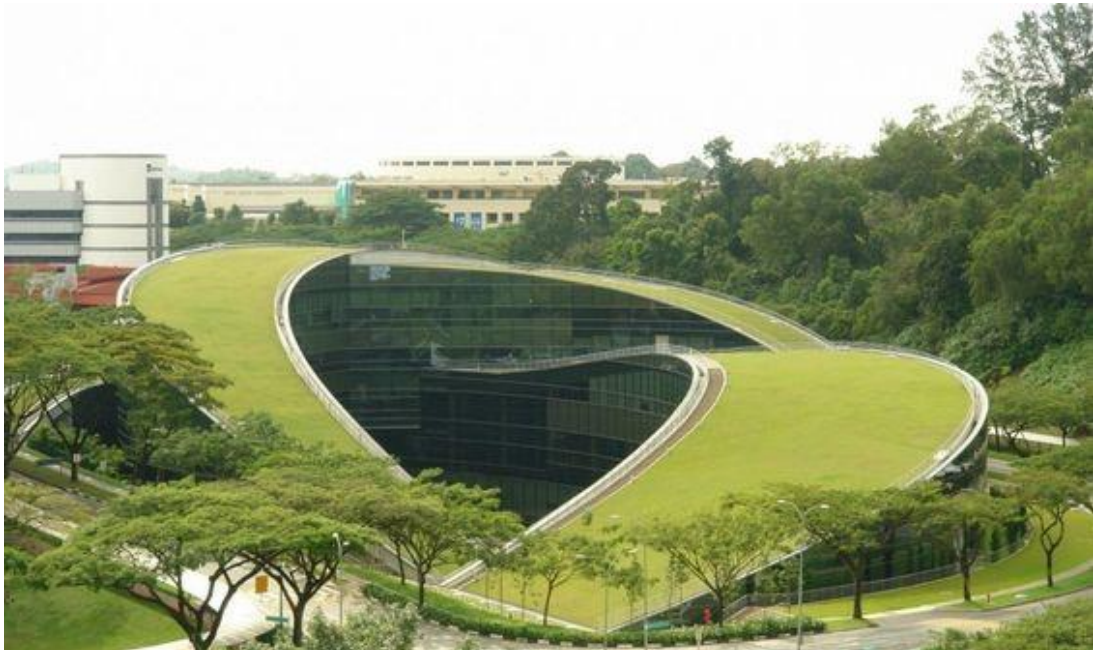
Figura 23- Cubierta verde /Universidad de tecnología Nanyang, Singapur.
