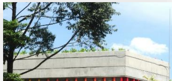
Figura 55- concreto a la vista
