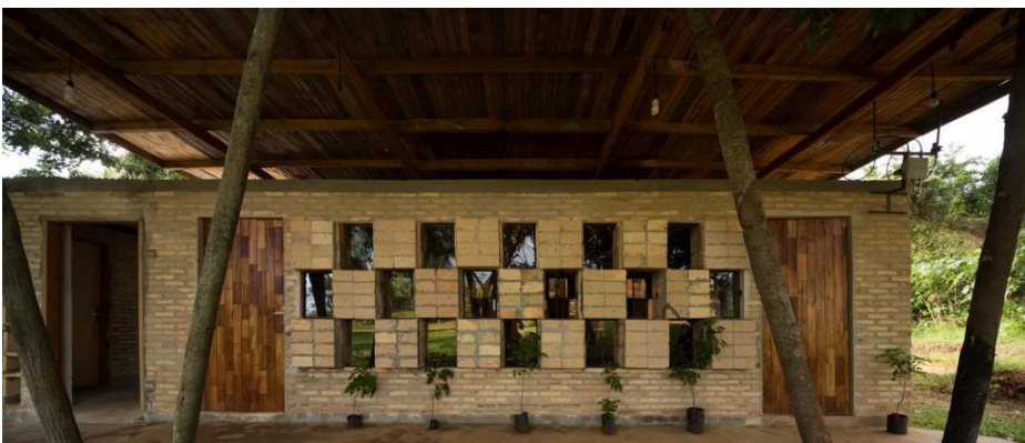
Figura 67- Fachada de la edificación
