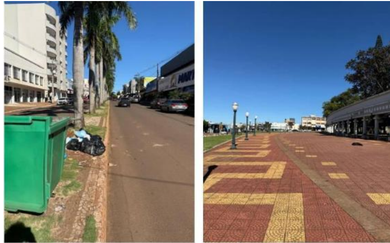
(Ausência de piso Tátil e obstáculos em locais de circulação)
