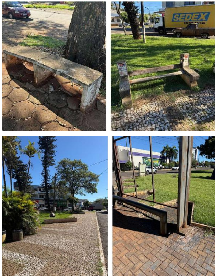
Figura 41: Mobiliário público deteriorado
