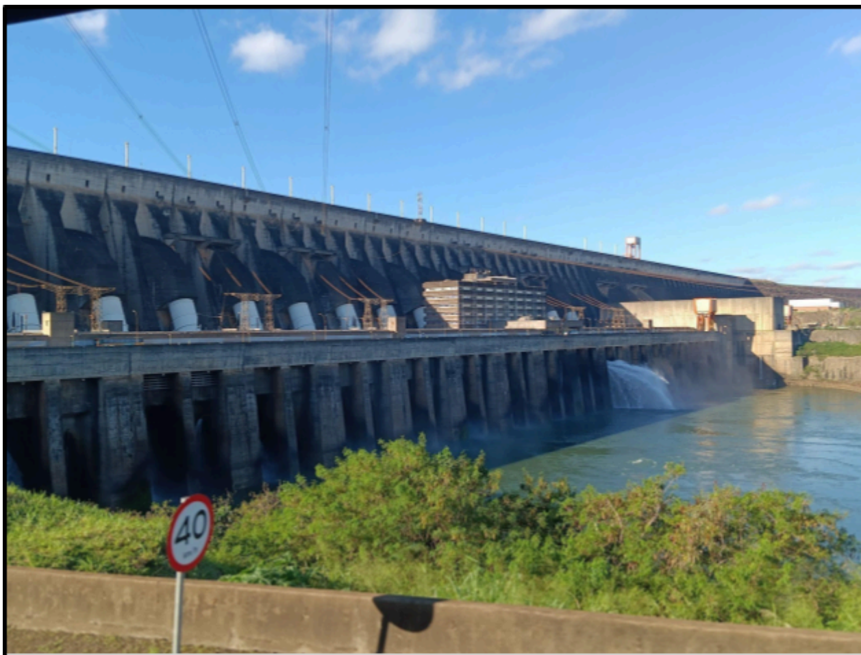
Foto 13 - Unidades Geradoras no interior da UHIB.
