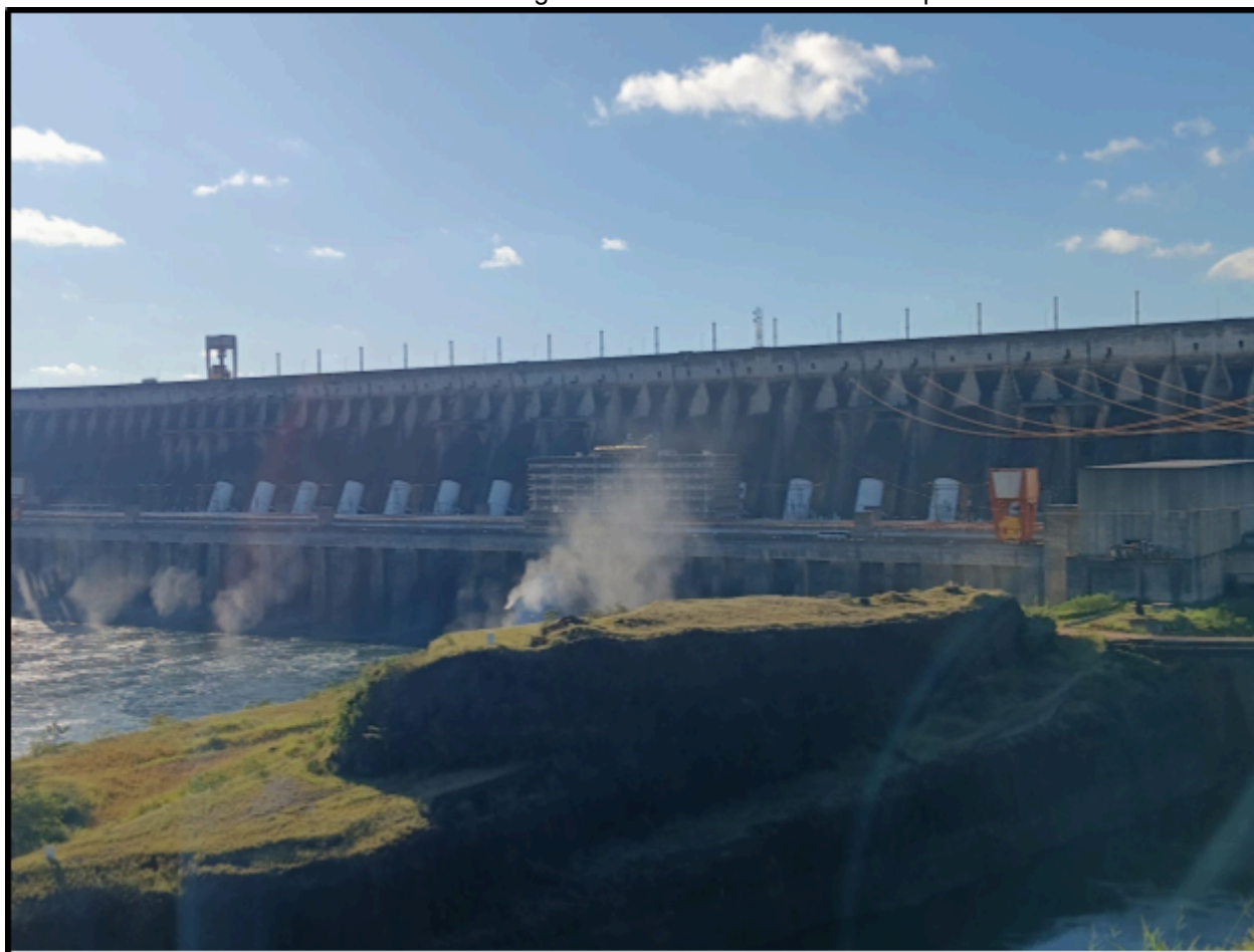
Foto 4 - Foto interna da barragem da Usina Hidrelétrica de Itaipu Binacional.
