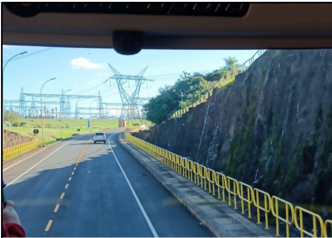
Foto 9 - Torres de transmissão elétrica no interior da UHIB.
