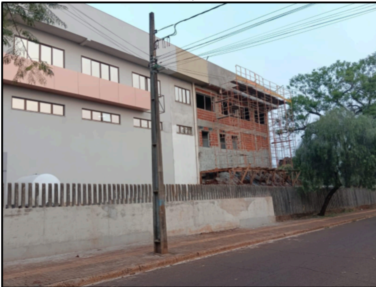
Foto 27: Ampliação do HMCC.
