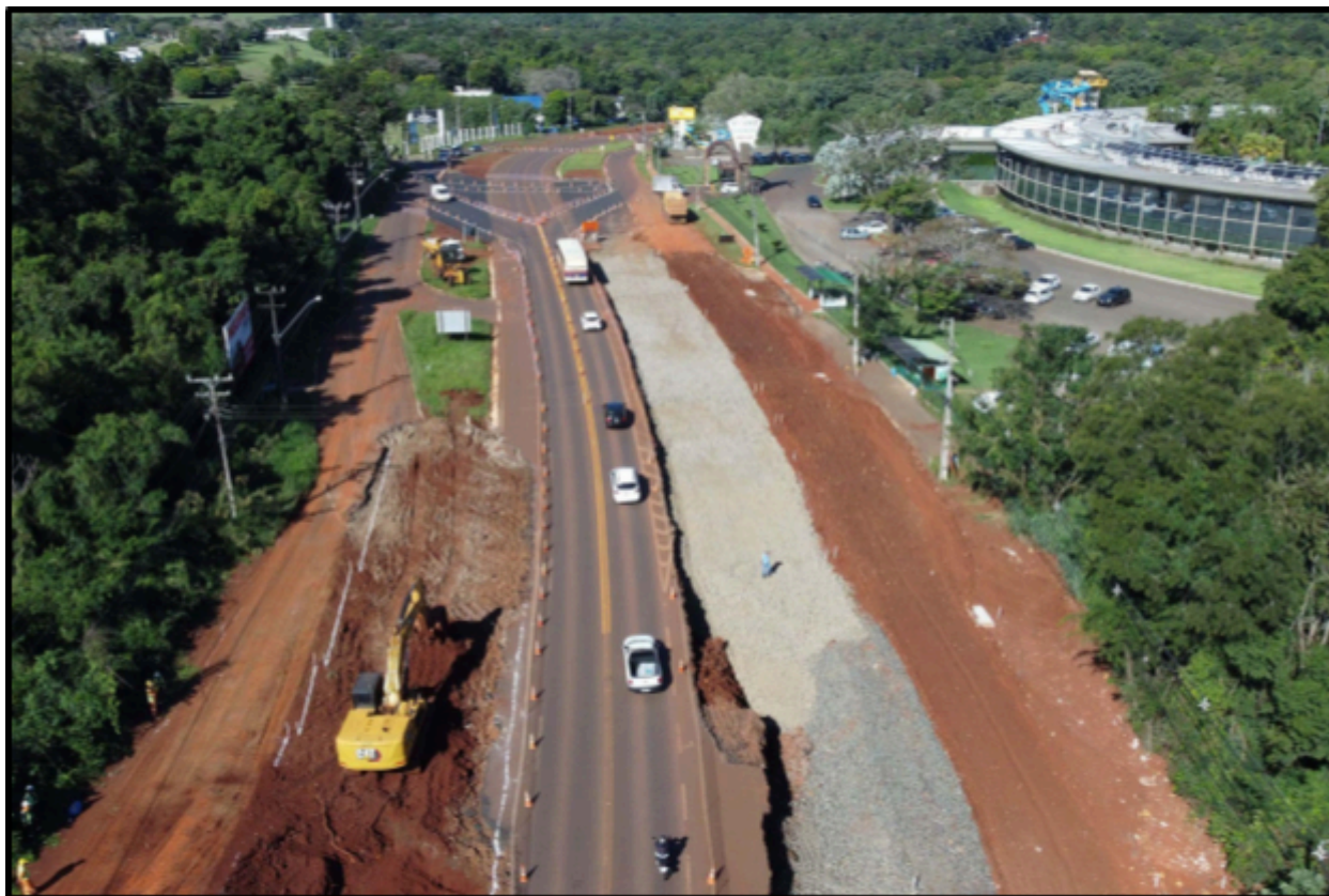
Foto - 19 :Ampliação da BR - 469.
