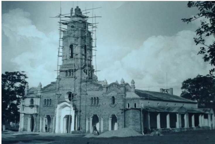
Figura 42: Momento de construcción del campanario, y terminación de la fachada.
