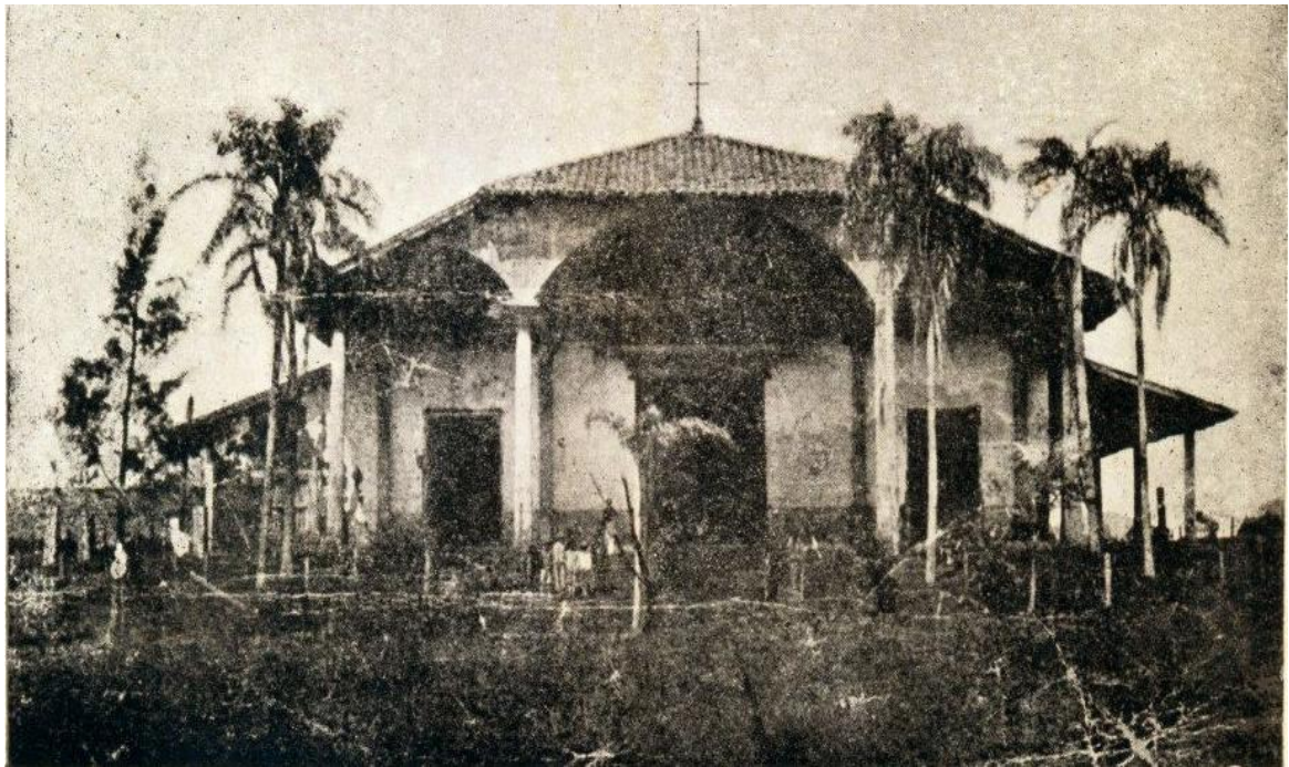
Figura 13: Fachada de la antigua Iglesia de San Ignacio Guazú, en estado de abandono inicio de los años 20.
