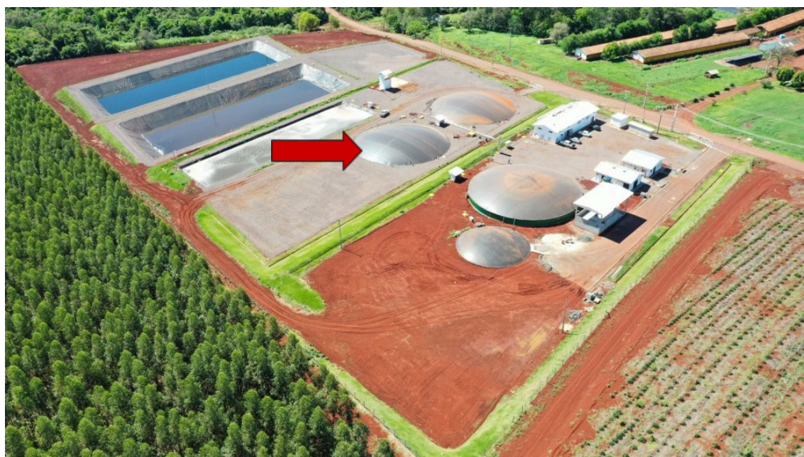
Figura 3 -Central de Bioenergia de Toledo (CSTR). Fonte: CibioGás, 2024 - Toledo, PR
