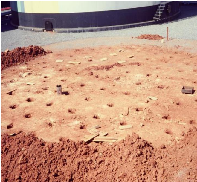
Figura 24: Execução Reforço Solo-cimento.
