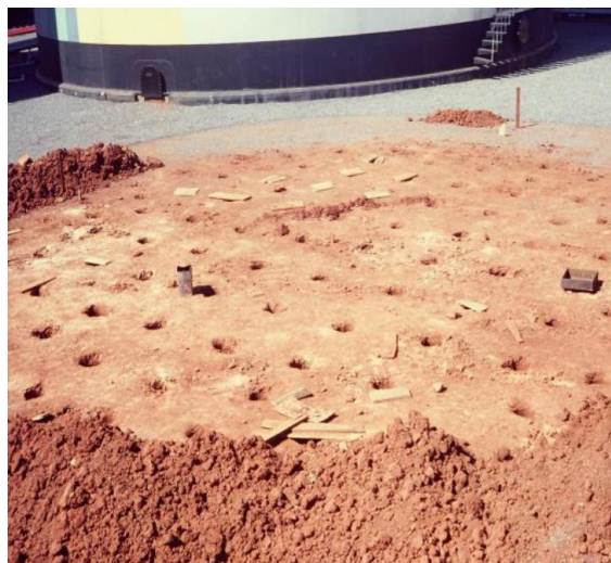
Figura 5: Colunas solo-cimento como apoio para Radiers.
