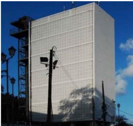
Figura 14 - Edifício Caixa d' Água, 1935 – Pernambuco – Br.
