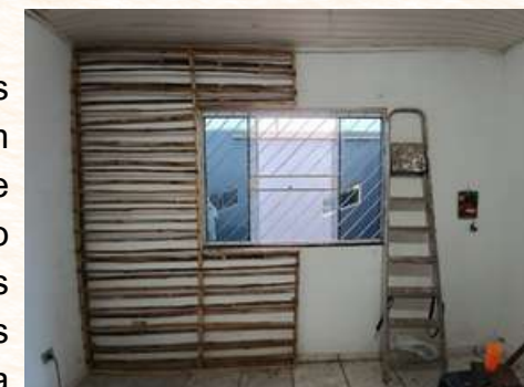
Figura 29: Instalación de la estructura en madera. Fuente: Imagen propia
