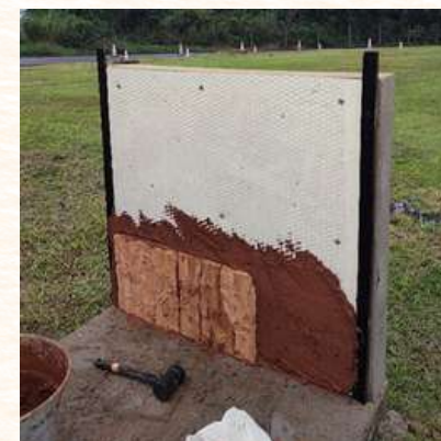
Figura 54: Instalación del panel de placa Fuente: Imagen propia
