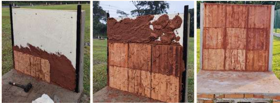
Figuras 59,60,61: Instalación de las placas de tierra Fuente: Imagen propia
