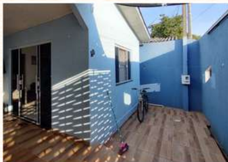
Figura 26: Parte exterior Fuente: Imagen propia
