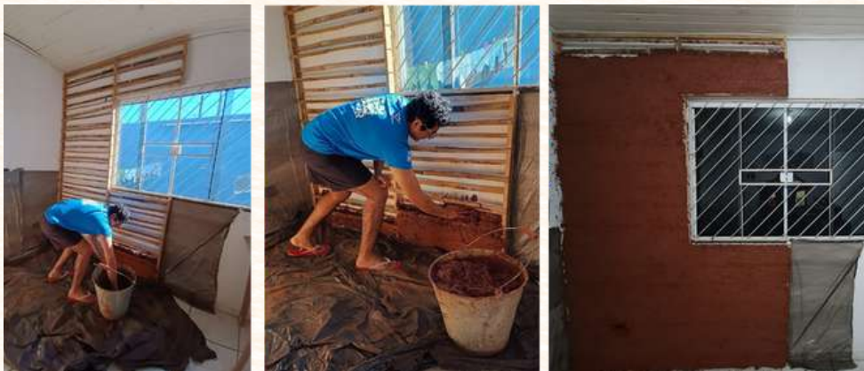
Figuras 30,31,32: Relleno del panel. Fuente: Imagen propia
