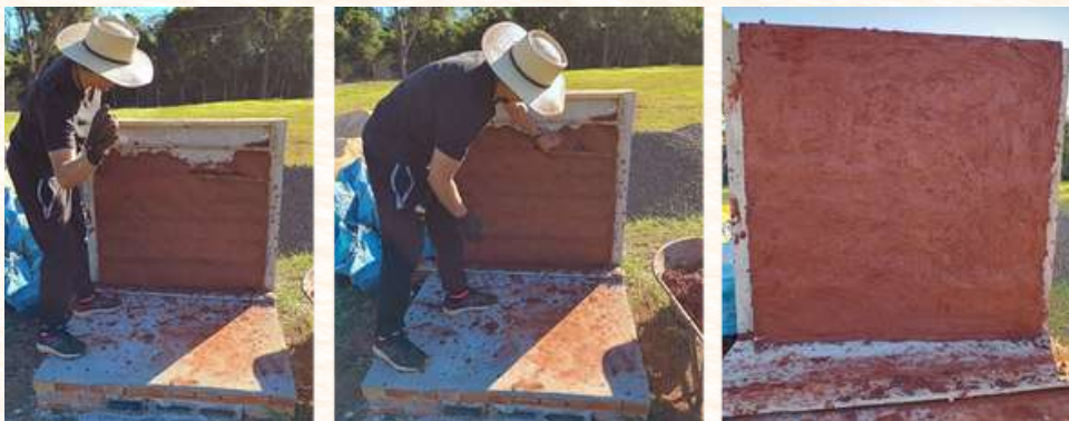
Figuras 46,47,48: Aplicación del mortero Fuente: Imagen propia
