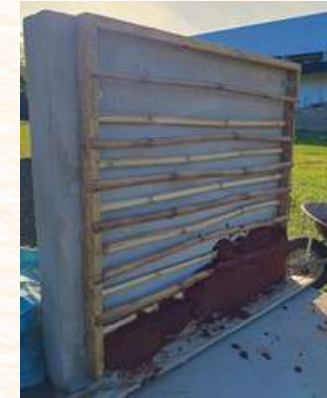
Figura 45: Anclaje de la estructura de madera Fuente: Imagen propia
