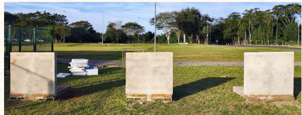
Figura 43: Finalización de los 3 muros de estudio Fuente: Imagen propia
