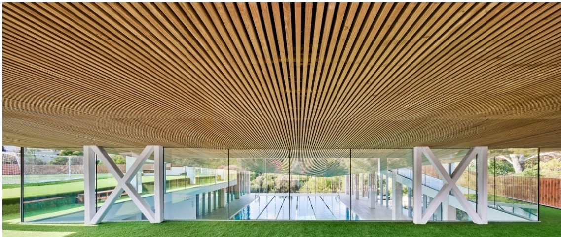
Figura 41 – Vista panorámica de instalaciones de la piscina, cerramientos vidriados y estructura metálica con cieloraso de madera.
