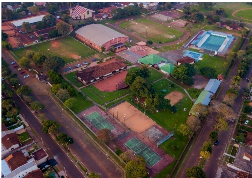
Figura 24 – Fotografía aérea con las instalaciones deterioradas y en desuso del Club Social Área 4.
