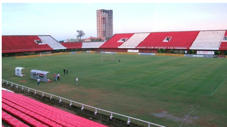
Figura 27 – Interior reacondicionado del estadio Antonio Aranda.
