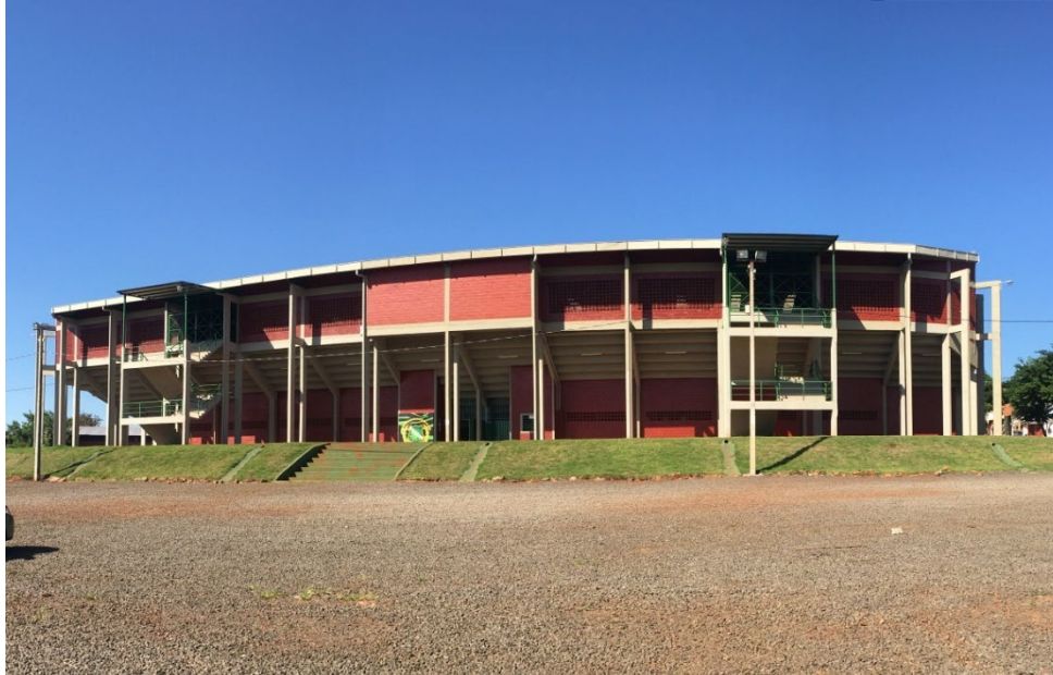
Figura 9 – Exterior del Polideportivo Don Carlos Barreto Sarubbi.
