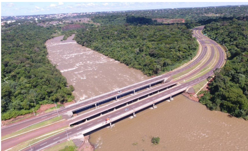
Figura 18 – Avenida República del Perú y en intersección el Río Acaray.
