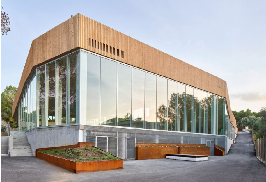
Figura 38 – Fachada Centro Deportivo Queen's Centre.
