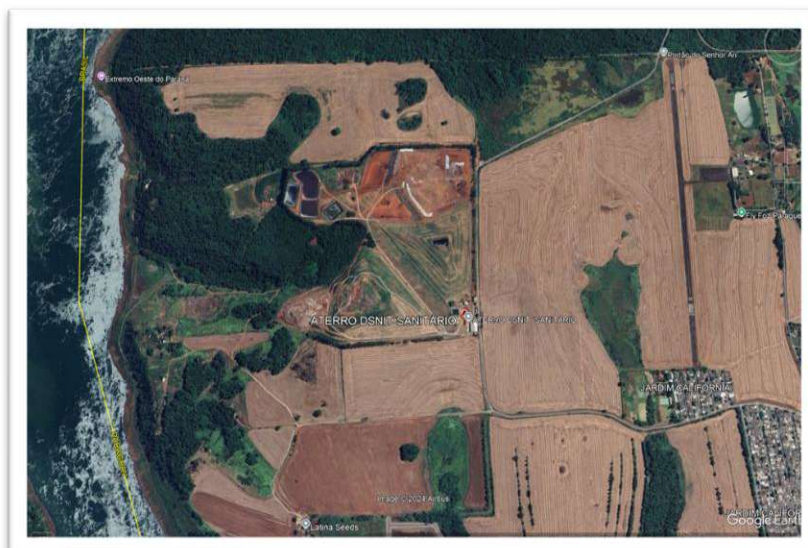
Figura 6 - Aterro Sanitário de Foz do Iguaçu
