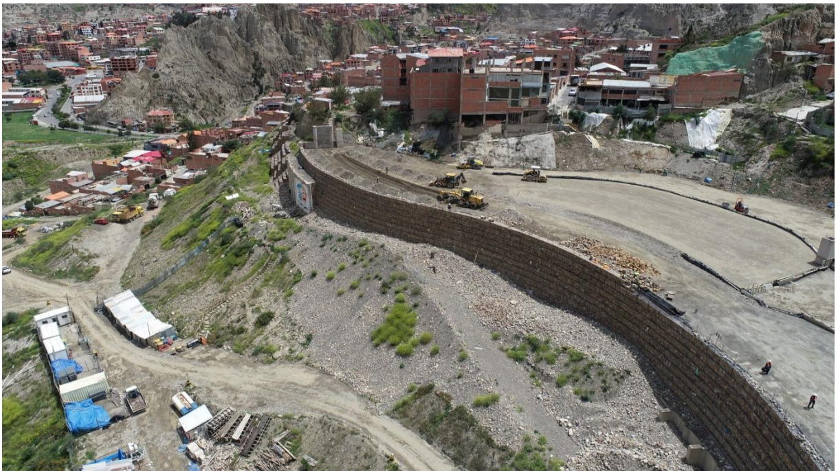
Figura 19 – Muro de gaviones, Kantutani.
