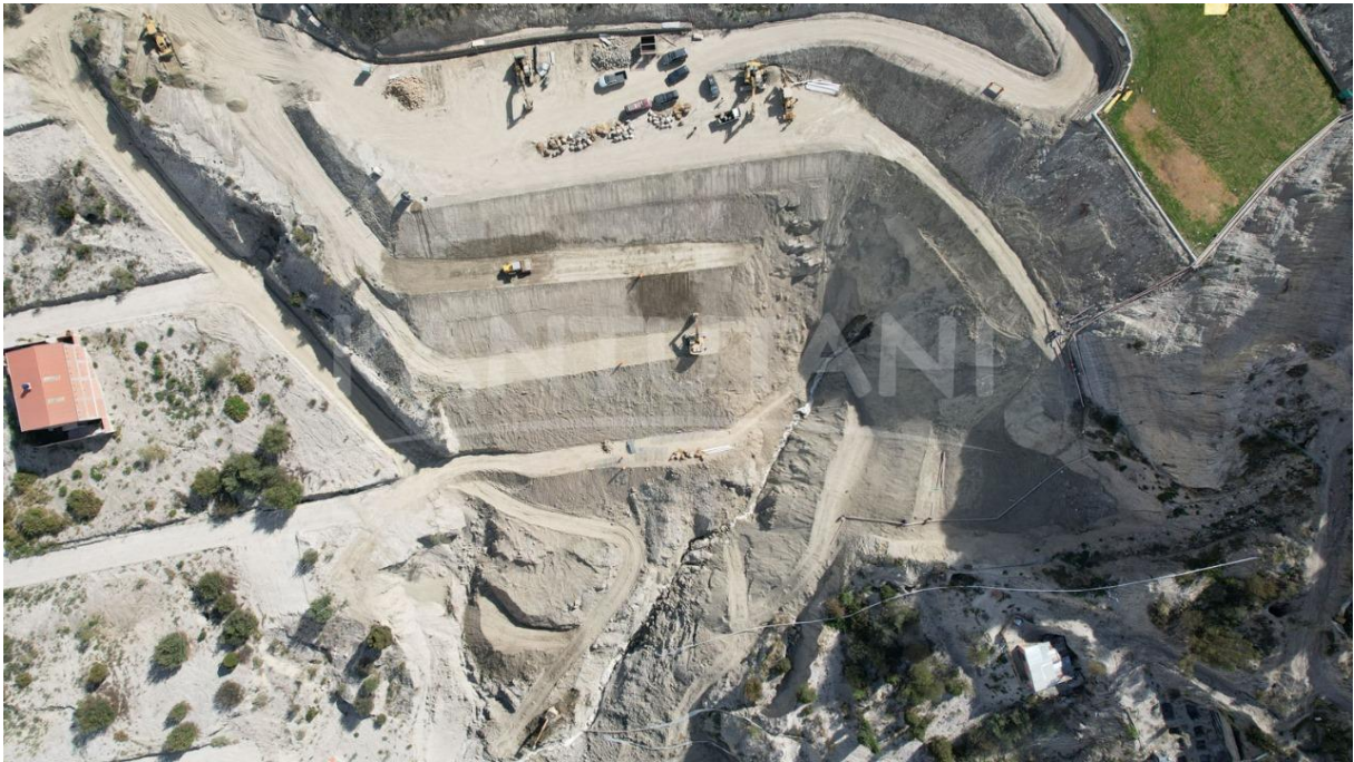
Figura 20 – Estabilización de taludes, región Bajo Llojeta.
