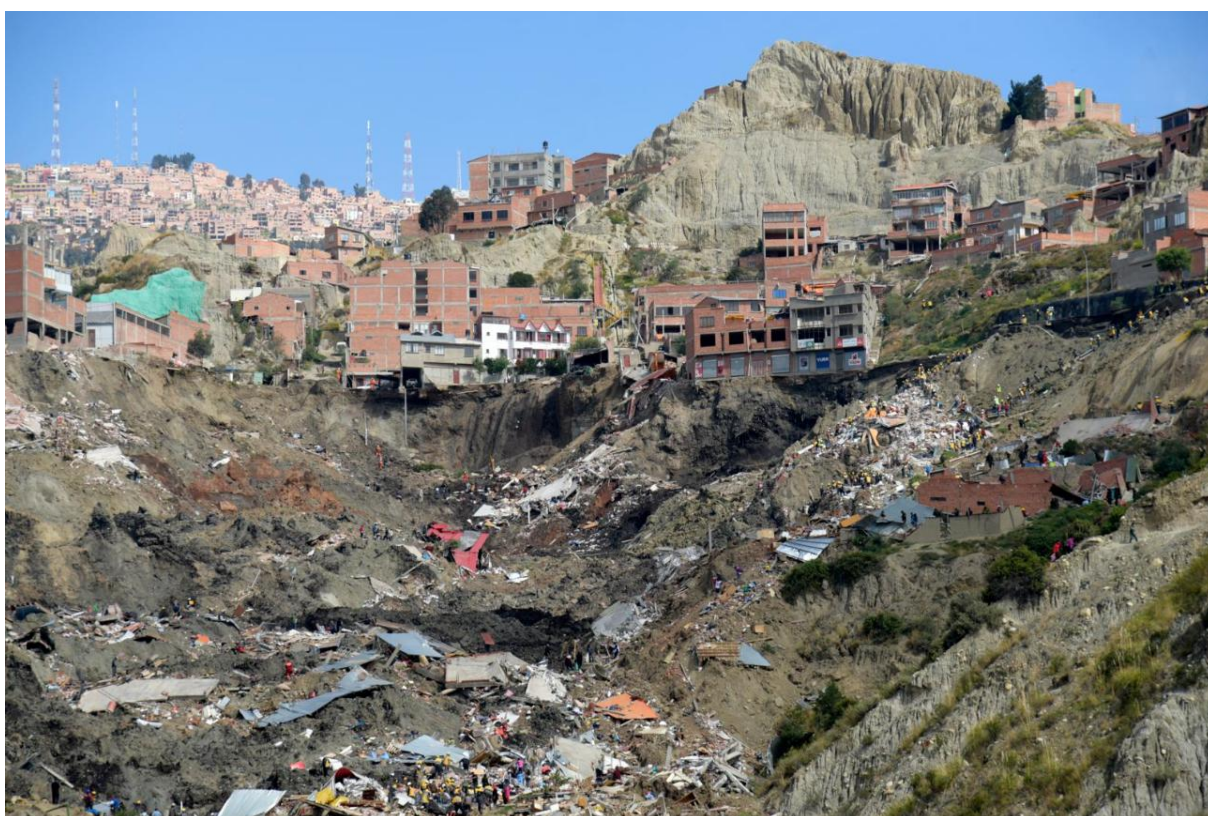
Figura 18 – Sector San Jorge-Kantutani, luego deslizamiento.
