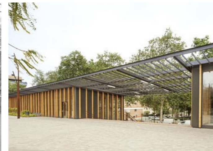
Figura 65- Vista externa acesso depois
