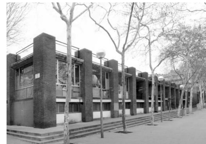
Figura 64- Vista externa acesso antes
