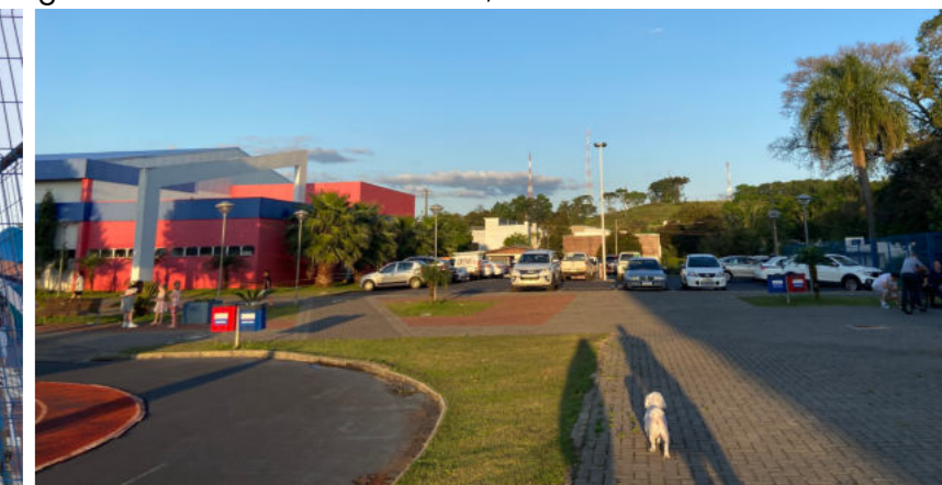
Figura 27- Acesso secundário, banheiros e estacionamento
