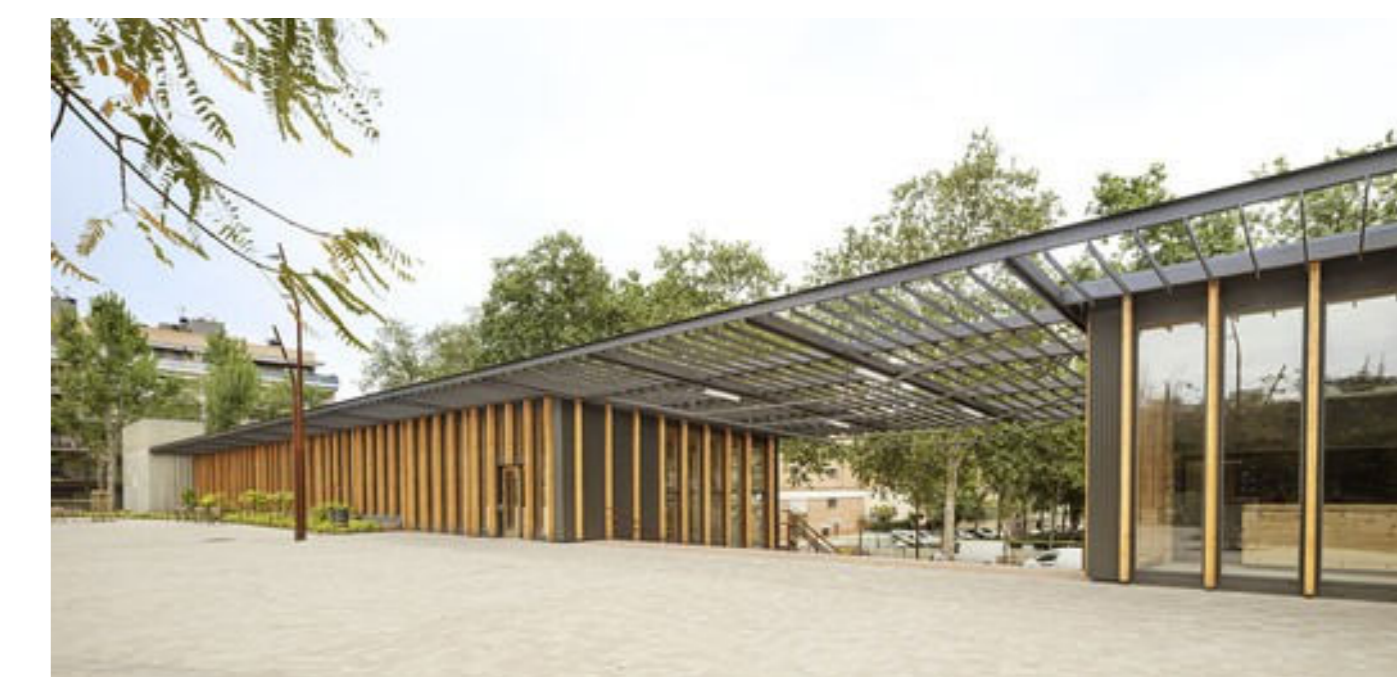
Figura 71- Acesso principal através do centro comunitário
