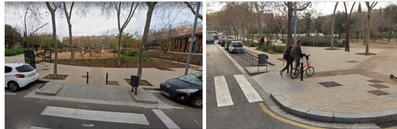
Figura 73 e 74- Imagens das calçadas acessíveis
