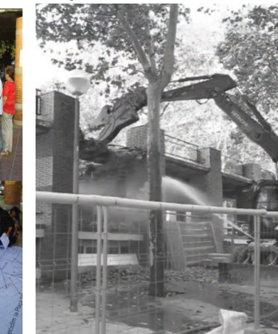
Figura 61- Processo de demolição
