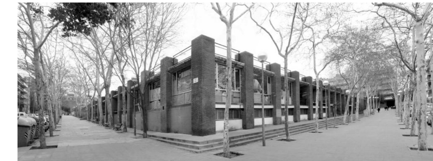
Figura 59- Vista externa antes da revitalização
