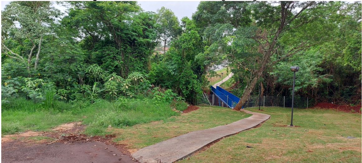
Figura 23 – Passarela sobre o Córrego Portuguesa
