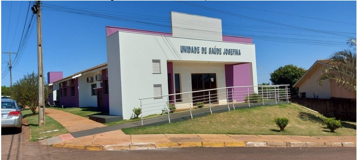
Figura 20 - Entrada com rampa de acesso
