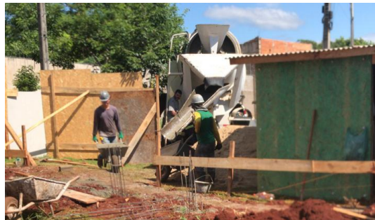
Figura 15 – Uso de OSB : a) uso do material em tapume e depósito (20S); b) painéis usados na estrutura de depósito, área de vivência e tapumes (18C); c) uso exclusivo em tapumes (6S)
