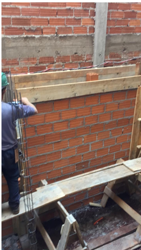
Figura 7 – Sistemas correntes de alvenaria: a) alvenaria em blocos cerâmicos; b) alvenaria em blocos de concreto
