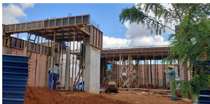
Figura 14 – Compensados plastificados: a) aplicação em pilares robustos e de vãos livres de 9,6 metros; b) substituição de compensados plastificados por elementos de madeira serrada
