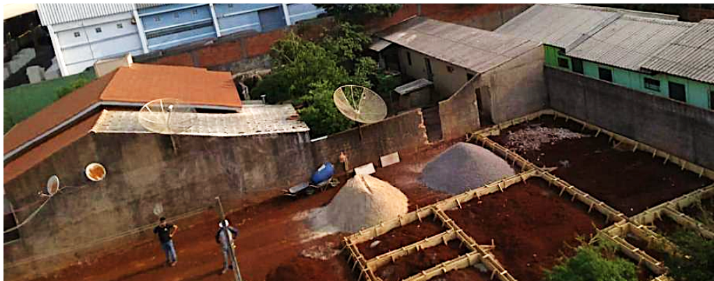
Figura 16 – Ausência ou substituição de elementos de madeira em canteiro: a) ausência de estruturas provisórias de canteiro e tapumes; b) muros nas extremidades do terreno; c) Telhas metálicas usadas como tapumes, cobertura de área de banheiro e uso de container
