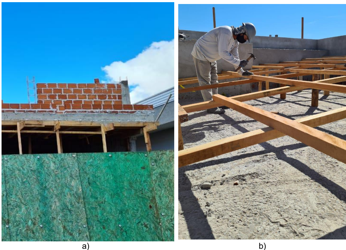
Figura 13 – Madeira usada de modo provisório – permanente (18C): a) uso provisório dos caibros de cambará como escora; b) aplicação dos caibros de cambara, que inicialmente foram usados como escoras, em estrutura permanente de cobertura
