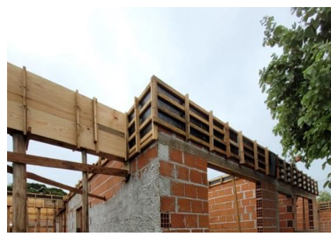
Figura 14 – Compensados plastificados: a) aplicação em pilares robustos e de vãos livres de 9,6 metros; b) substituição de compensados plastificados por elementos de madeira serrada
