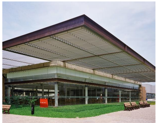
Figura 63- Cobertura metálica, paredes cortina y brises en restaurante.
