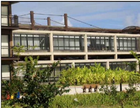
Figura 52- Vista externa de las salas de aulas.
