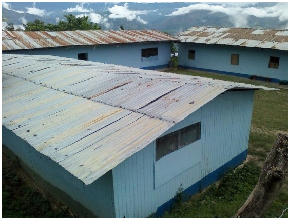
Figura 93- Exteriores d la moradia
