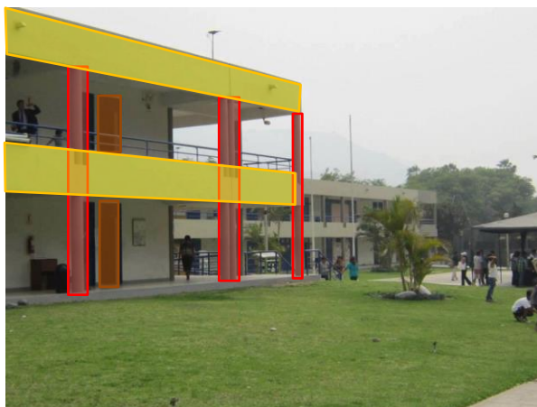
Figura 39- Área donde se aprecia la tecnología constructiva que se utilizó.
