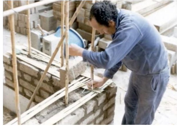
Figura 13- Construcción de paredes con adobe
