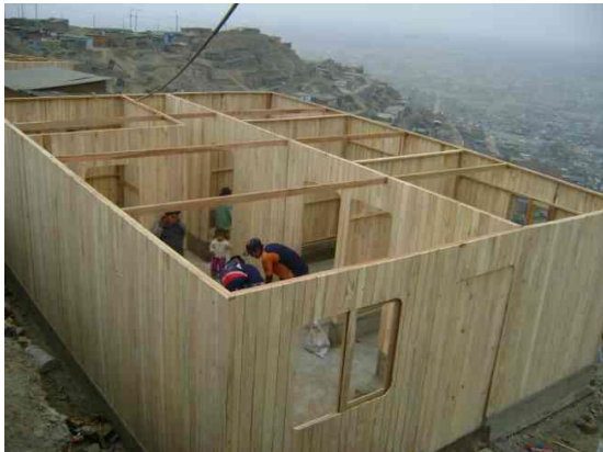
Figura 18- Construcción de casas con madera prefabricada.
