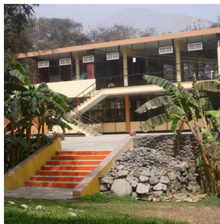
Figura 40- Área donde se aprecia la tecnología constructiva que se utilizó.
