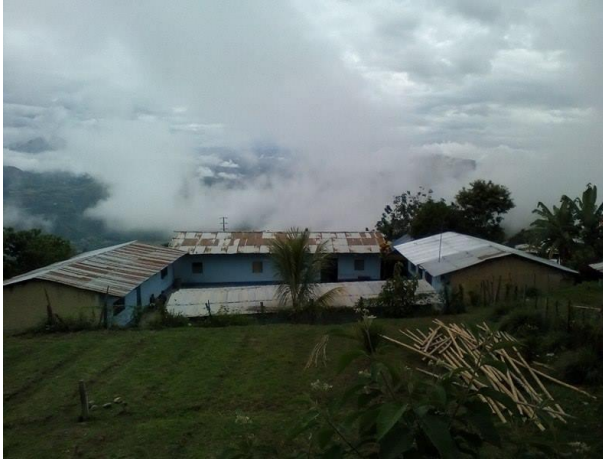
Figura 122 – Vista externa de las edificaciones existentes.
