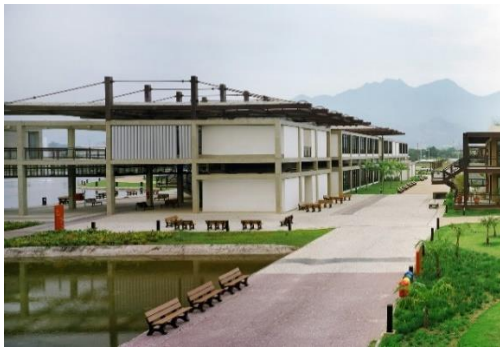
Figura 49- Pasarelas y pilotes en la sala de aulas.
