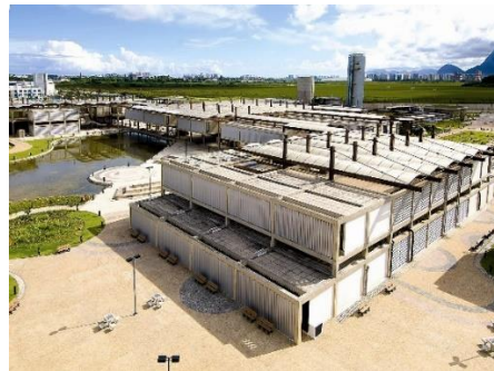
Figura 50- Sistema modular en salas de aula.
