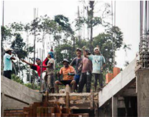
Figura 78- Proceso de construcción del sistema estructural.
