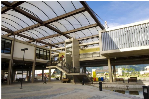
Figura 62- Tecnología constructiva utilizada en la construcción de las salas de aulas.
