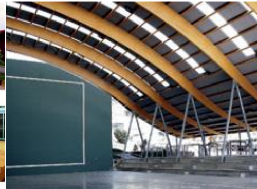
Figura 17- Vigas, correas en madera industrial.
