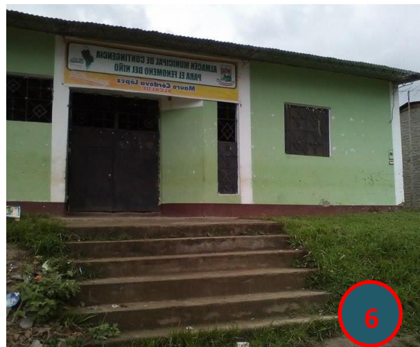
Figura 107 – Casa Comunal del Distrito de SJL
