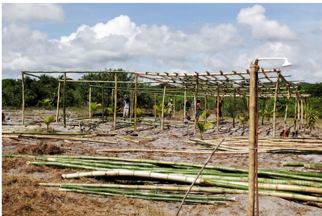
Fotografía 28 - Tercer día de construcción de la primera estructura
