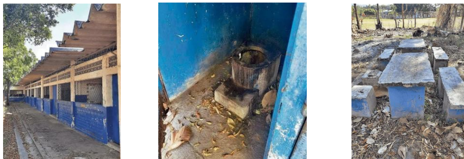
Figura 11- Instalaciones del Centro Escolar Santa Teresa, ubicado en Chalatenango
