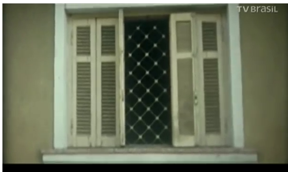
Figura 49: Janela da antiga casa de Rodolfo
