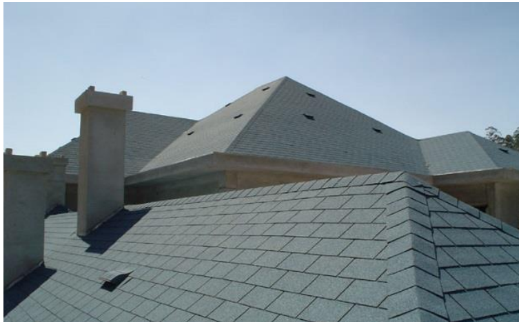
Figura 10- Cobertura com telhas shingle (TCSHINGLE, 2015).
