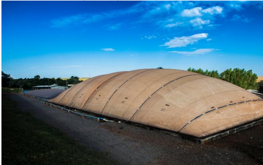
Figura 1 Biodigestor tipo Lagoa coberta
