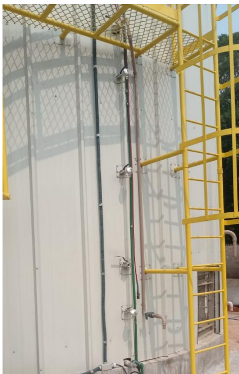
Figura 20 - Ponto de coleta de biogás.
