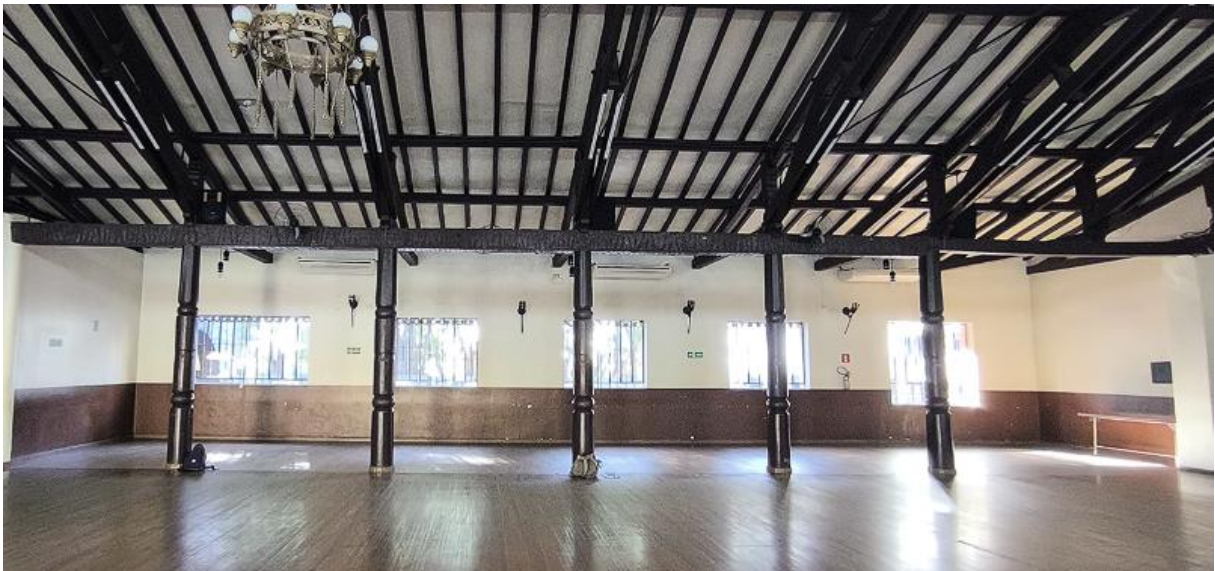
Figura 48: Verificação de Integridade dos Elementos do Salão
