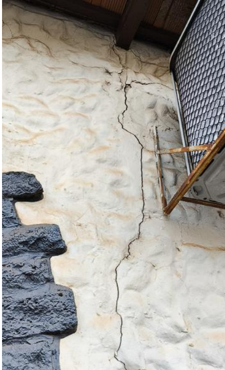
a) Encunhamento de Alvenaria
