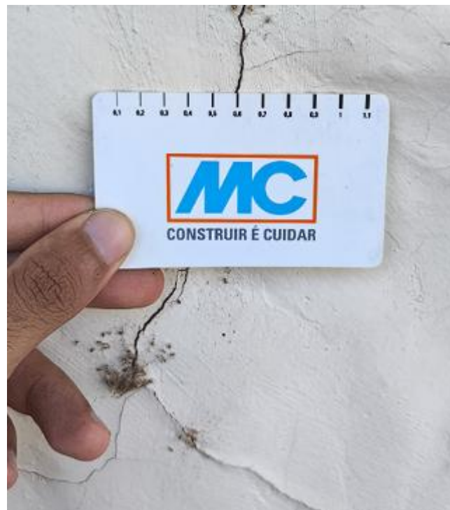
Figura 18: Utilização de Fissurômetro
