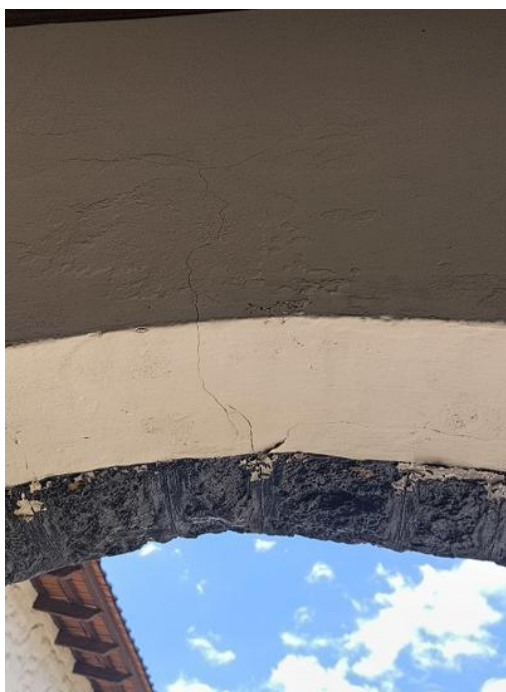
c) Arco 2, Parte interna
