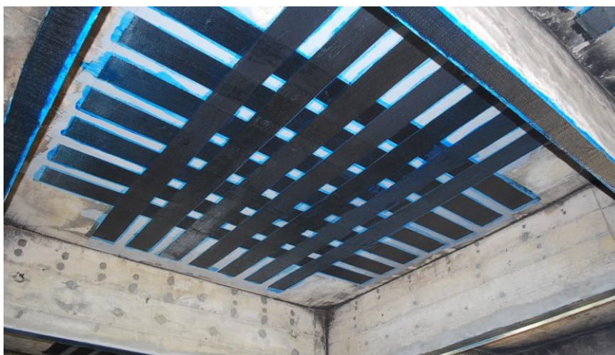
Figura 47: Reforço Com Fibra de Carbono em Laje
