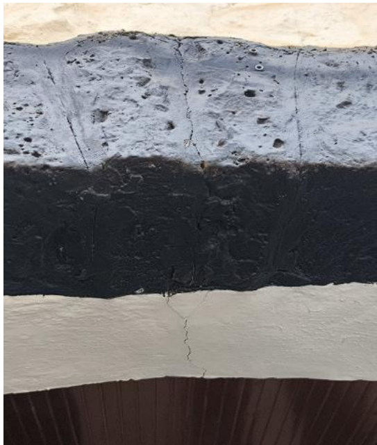
a) Arco 1, Parte Externa
