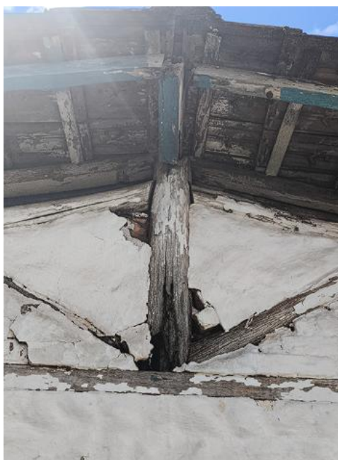
a) Fachada Sul Casa de Máquinas
