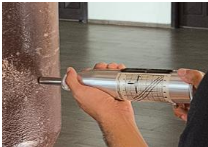
Figura 12: Aplicação do Martelo Schmidt
