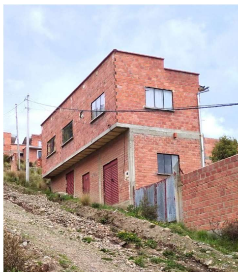
Foto 3 - Vivienda autoconstruida de 2 niveles en pendiente
