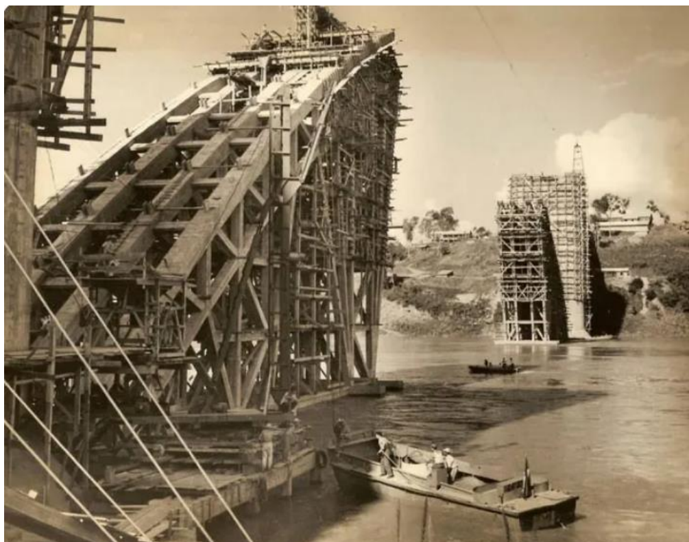
Figura 5- Construção Ponte da Amizade não Datada
