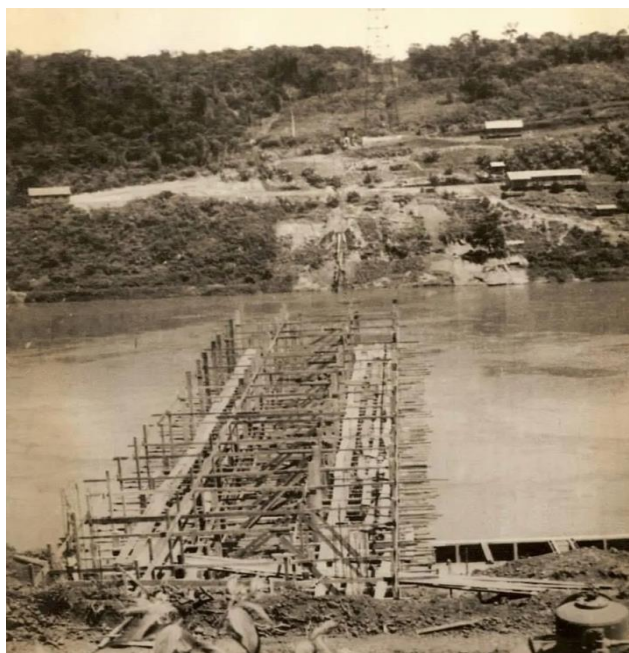
Figura 3- Início da Construção da Ponte nos Anos 50
