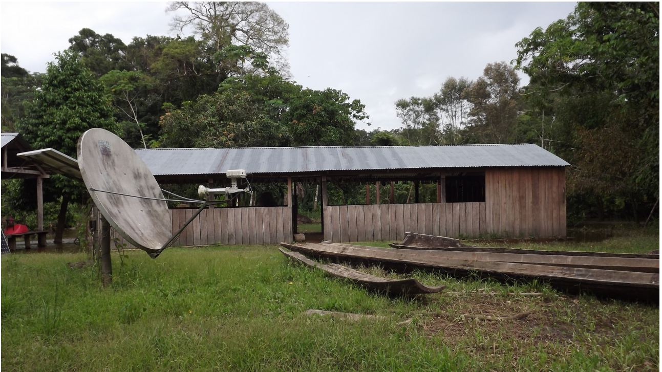
Fotografia 20: Infraestrutura da comunidade de Santa María: painéis solares, antenas de rádio e centro comunitário de reuniões.
