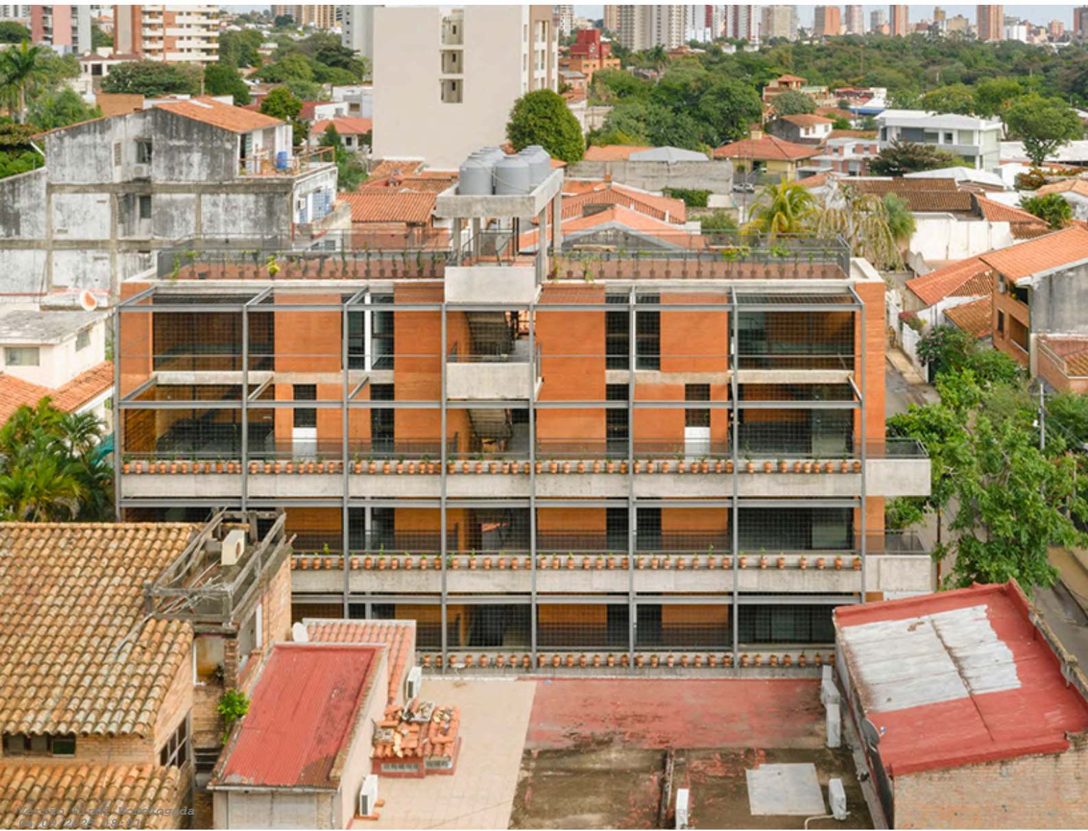
Figura 20: Fachada lateral del proyecto.
