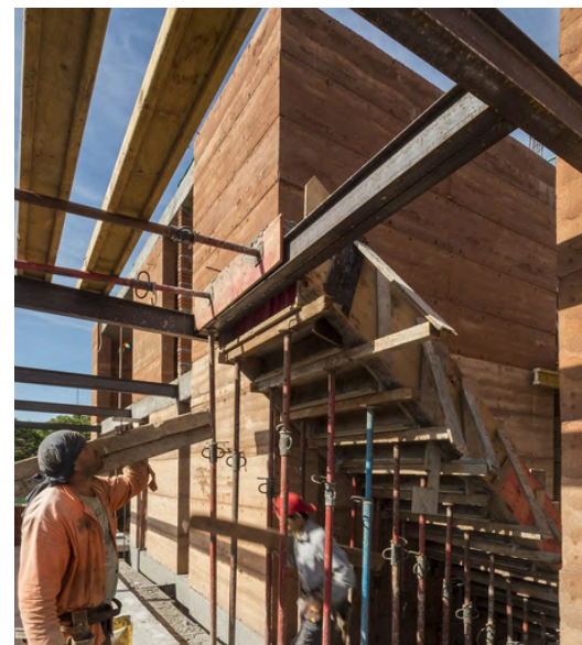
Figura 24: Ejecución de la escalera.
