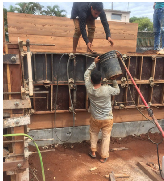
Figura 23: Elaboración de los muros con tierra.
