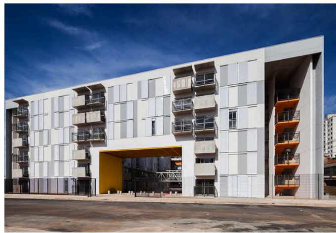
Figura 39: Fachada del proyecto.
