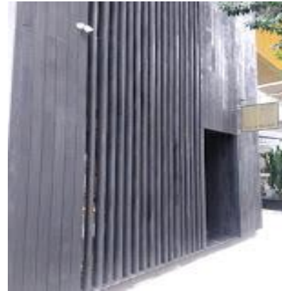
Figura 3-21: Brise vertical em loja na rua Oscar Freire-SP.
