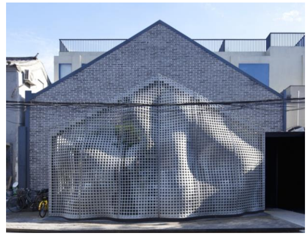
Figura 3-30: Elemento complexo em fachada do Edifício Small Scale em Beijing-China.
