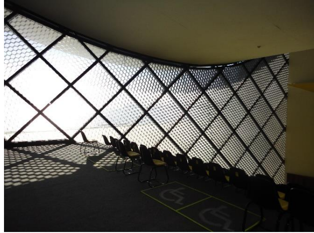
Figura 3-16: Grade metálica na fachada do edifício Teatro Popular Oscar Niemeyer.
