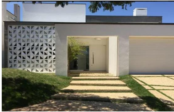
Figura 3-13: Elemento vazado em residência de Foz do Iguaçu-PR.
