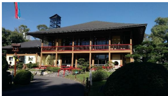
Figura 3-10: Varanda Edifício no Jardim Japonês em Buenos Aires.
