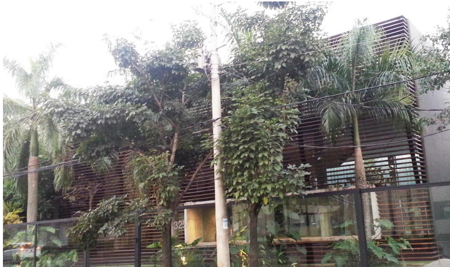
Figura 3-22: Brise horizontal no Edifício Colombia 325-SP.
