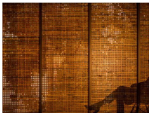
Figura 3-32: Elemento de Controle Solar com obstrução da vista externa
