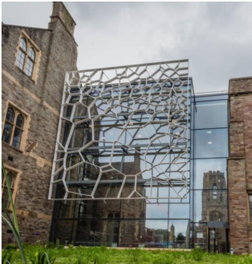
Figura 3-27: Elemento de sombreamento complexo em formato Voronoi.
