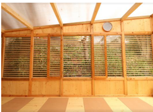
Figura 3-31: Elemento de Controle Solar sem obstrução da vista externa
