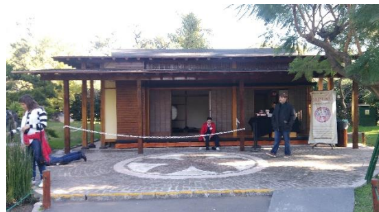
Figura 3-18: Beiral em Edifício no Jardim Japonês em Buenos Aires.
