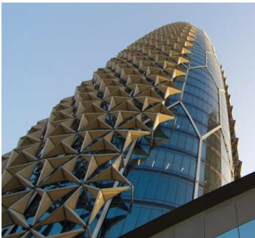
Figura 3-29: Elemento de controle solar do Edifício Al Bahar Towers
