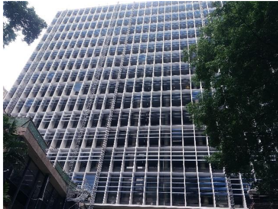
Figura 3-20: Brises mistos (verticais e horizontais), no Palácio Gustavo Capanema-RJ.
