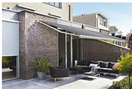
Figura 3-24: Toldo sobre porta janela.
