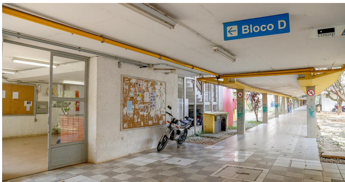
Figura 21 - Circulação coberta bloco D.
