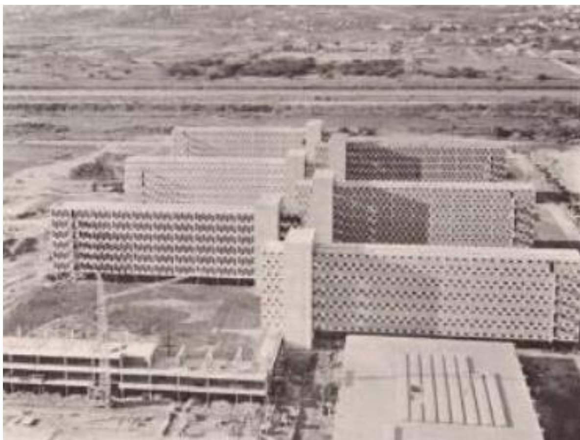
Figura 8 - Vista aérea durante a construção do CRUSP.
