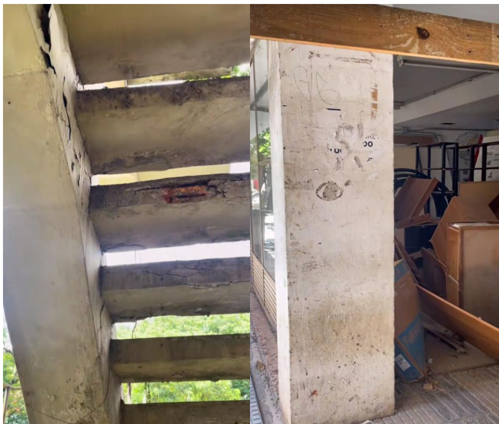
Figura 26 - Escada externa, e corredor.
