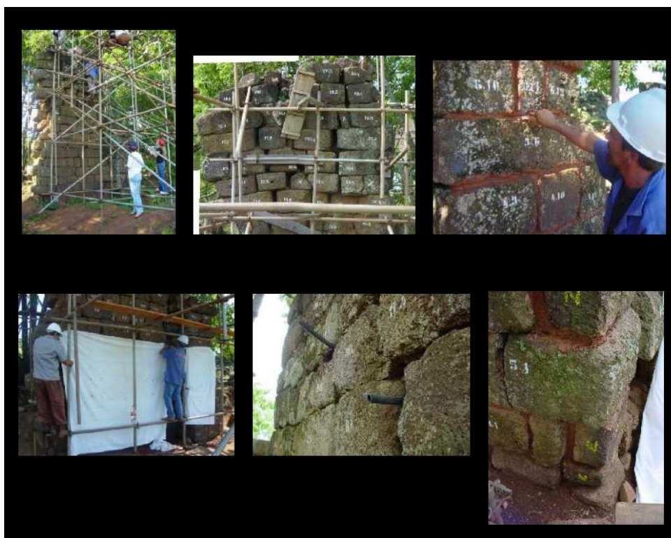
Figura 33 – Intervenção de consolidação das pilastras de São Lourenço.
