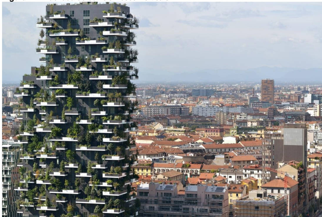
Figura 17 - Fachada do edifício Bosco Verticale
