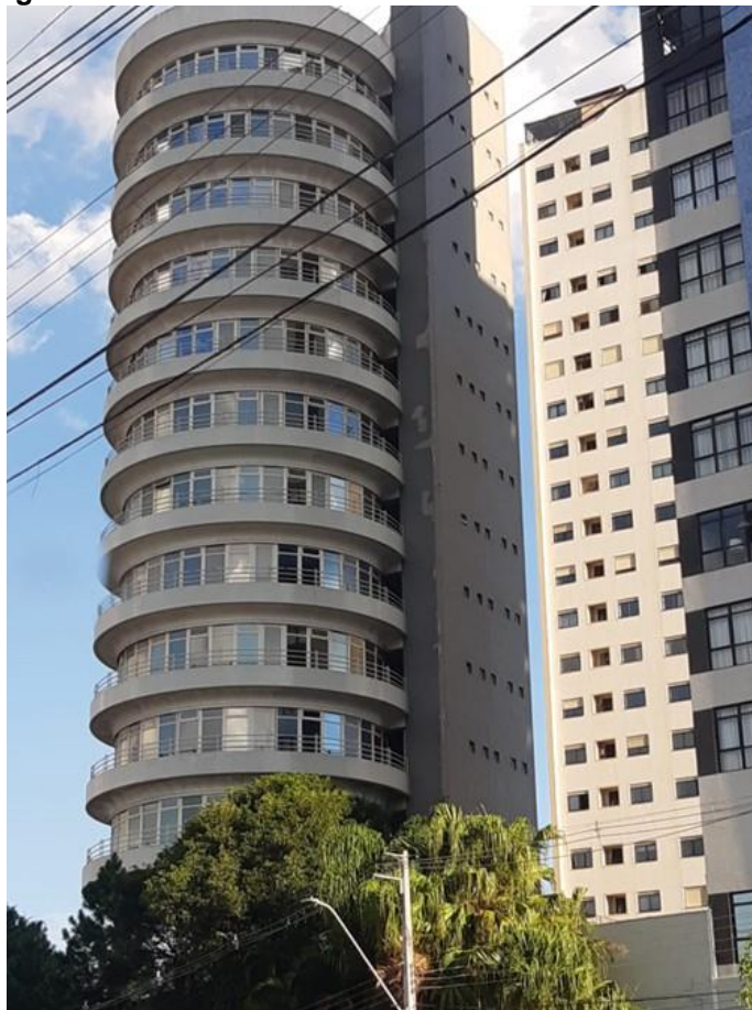
Figura 7 - Fachada do edifício Suite Vollard
