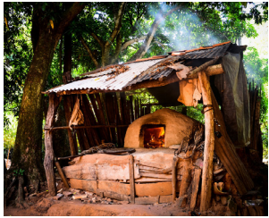
Tatakua: Hornode leña construida con ladrillo y mezcla de tierra utilizadas para cocinar alimentos, esencialmente la sopa y chipa paraguaya
