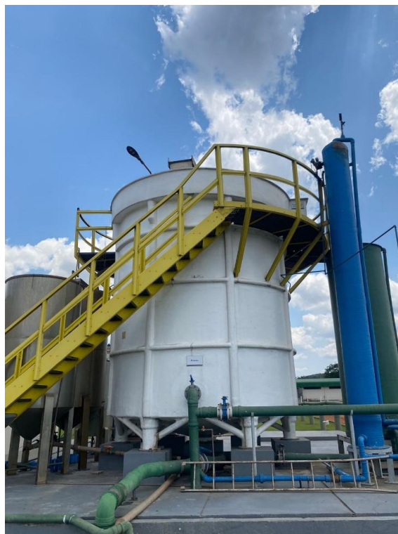
Figura 10 – Flotador
