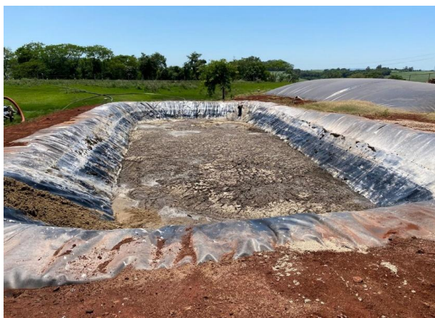
Figura 12 – Lagoa de digestato
