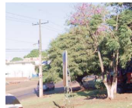
Figura 175. Poste de energía eléctrica. Fuente: Autoría propia 2021
