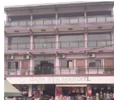
Figura 146. Avenida Choferes del Chaco. Fuente: Autoría propia 2021
