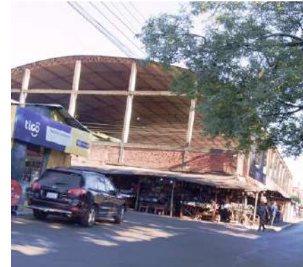
Figura 162. Avenida Choferes del Chaco. Fuente: Autoría propia 2021
