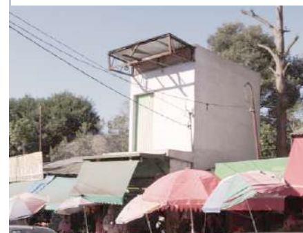
Figura 144 Avenida Choferes del Chaco. Fuente: Autoría propia 2021
