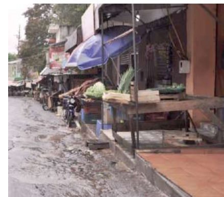
Figura 195. Avenida Choferes del Chaco. Fuente: Autoría propia 2021
