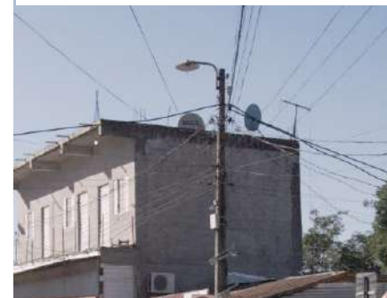
Figura 173. Poste de energía eléctrica. Fuente: Autoría propia 2021
