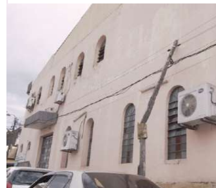
Figura 165. Avenida Choferes del Chaco. Fuente: Autoría propia 2021
