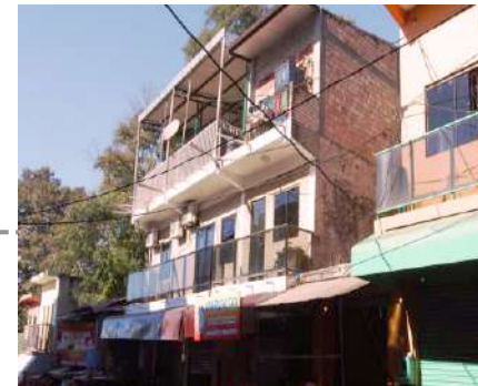
Figura 94. Edificación de 3 pav. Fuente: Autoría propia 2021
