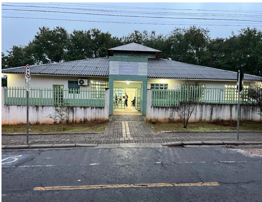
Imagem 1 – Parte exterior UBS Morumbi II
