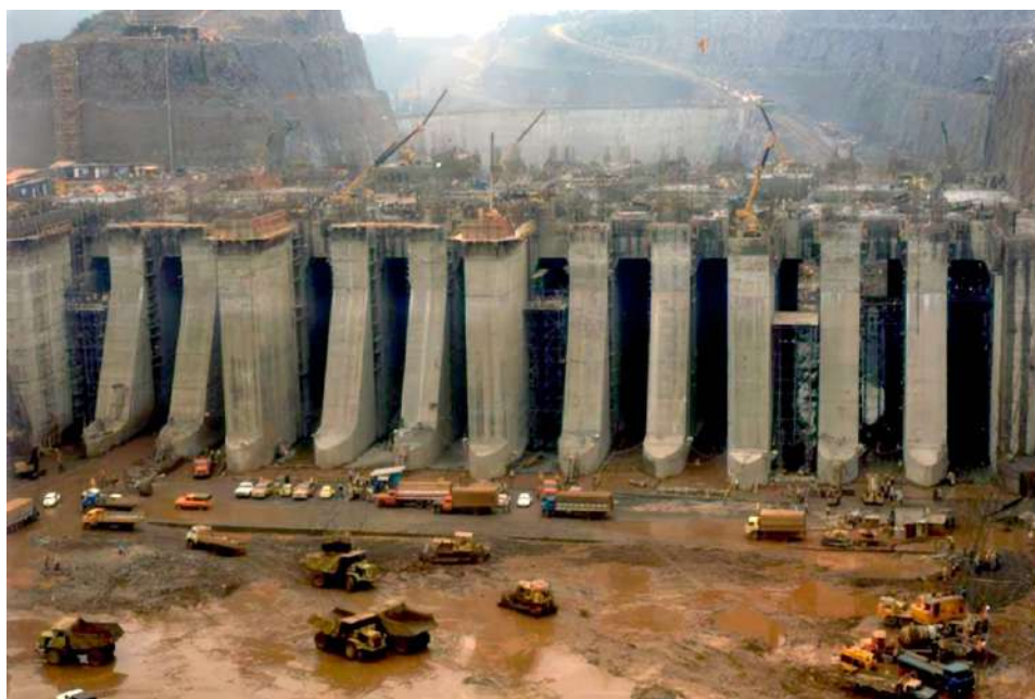
Fotografia 1: Construção da barragem de Itaipu
