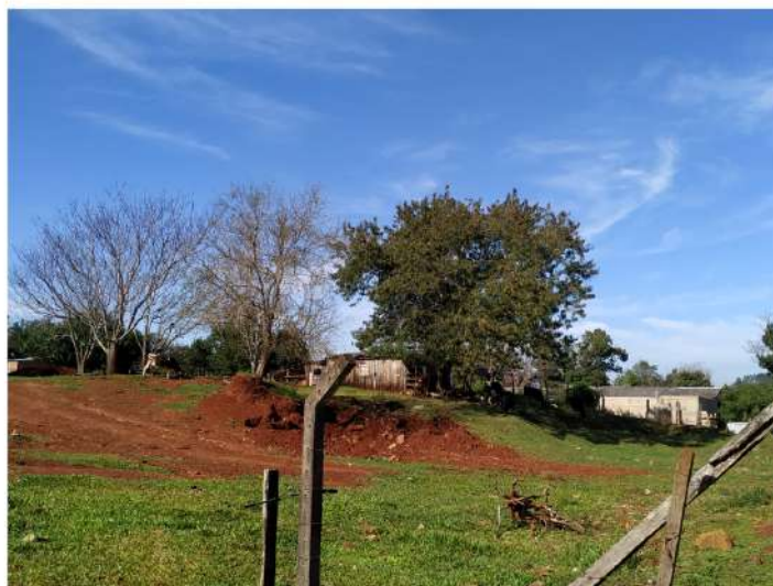
Figura 9: processos erosivos no Arroio Dourado
