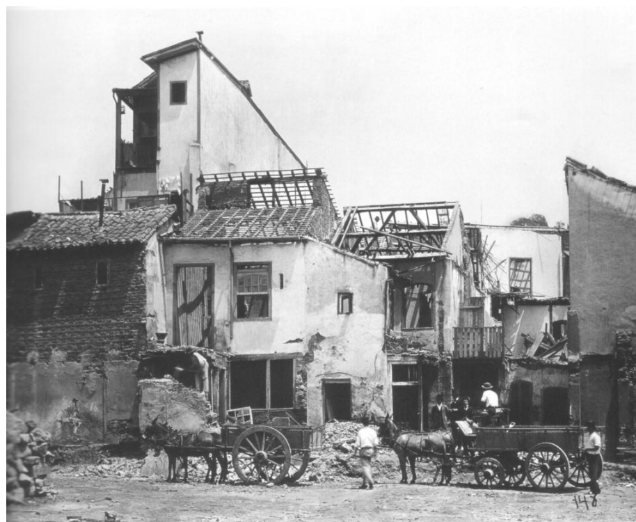
Fig. 16 Demolición de cortiços en Rio de Janeiro, 1904 Fuente: Ruchaud, 2011
