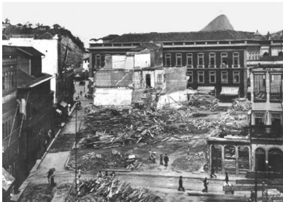
Fig. 15 Demolición de cortiços en Rio de Janeiro 1903 Fuente: Ruchaud, 2011
