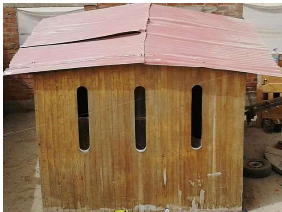
Fig. 8 Casa con techo de calamina
