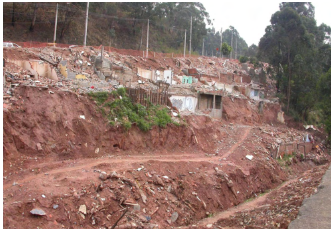
Figura 48: Remoção de construções irregulares na área de risco
