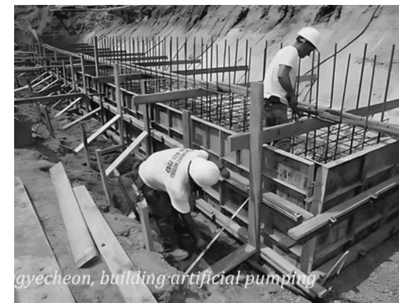
Figura 34: Construção do bombeamento artificial
