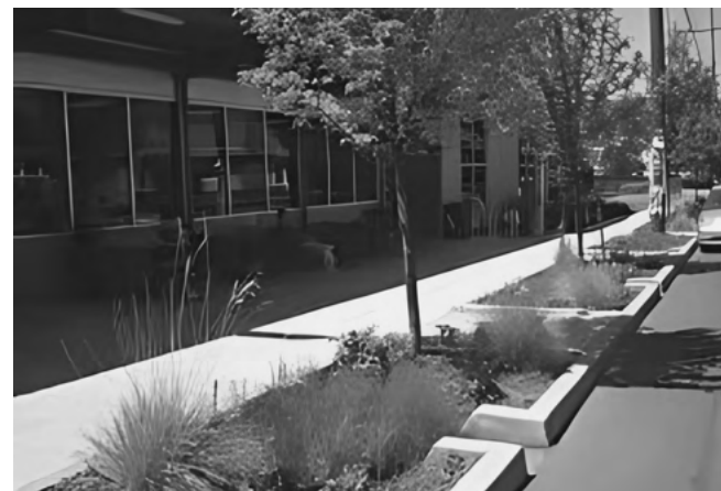
Figura 28: Canteiros pluviais no New Seasons Market, em Portland
