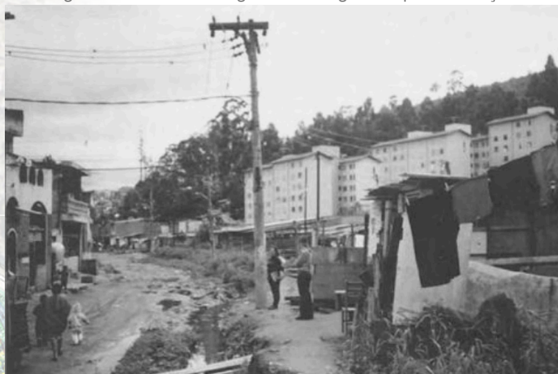
Figura 46: Avenida Hugo Ítalo Merigo sem pavimentação
