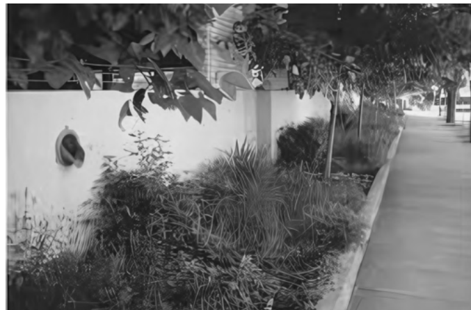
Figura 27: Canteiro pluvial ao lado da garagem do Liberty Center
