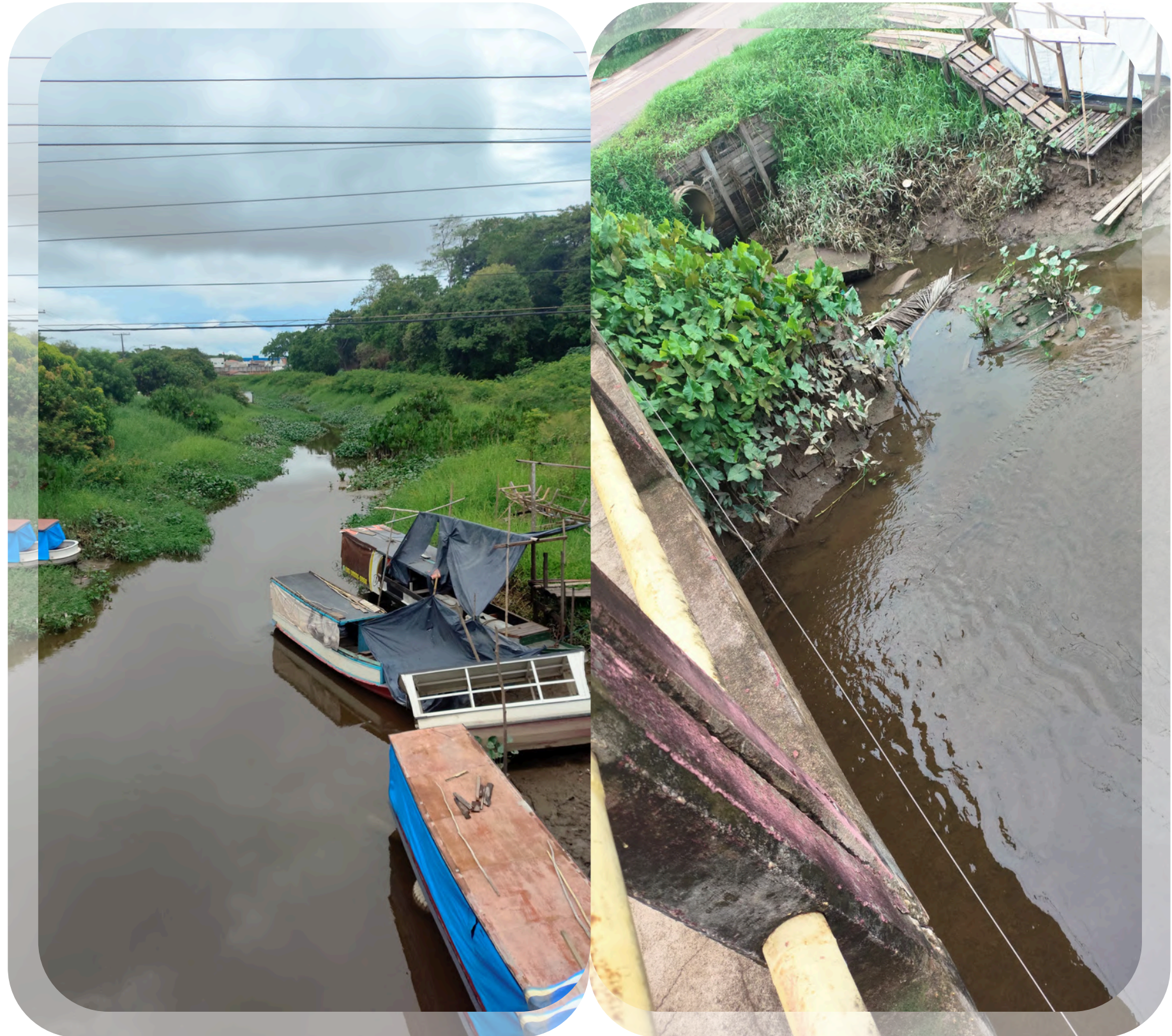
Figura 44 - Fotos do assoreamento do lado da Ponte do Canal do Jandiá, no trecho médio do canal. Fonte: Daniela A. A. Olivo, 2024*.
