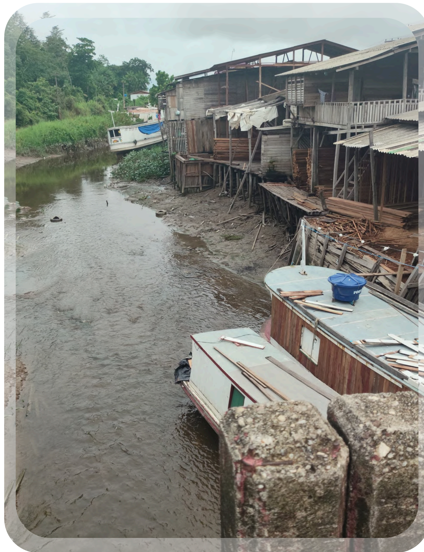
Figura 10 - Construções na margem do Canal do Jandiá, em Macapá, AP. Fonte: Daniela A. A. Olivo, 2024.
