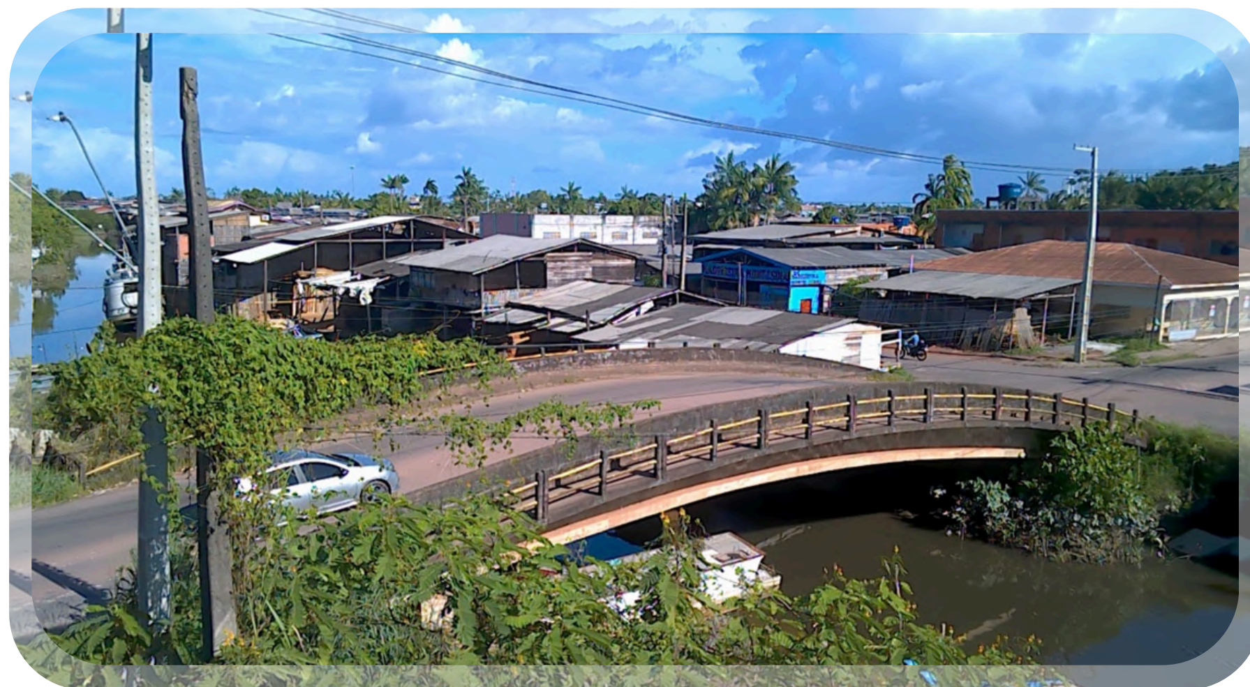
Figura 45 - Foto aérea das edificações ao redor do trecho 1 do Canal do Jandiá. Fonte: Daniela A. A. Olivo, 2025.
