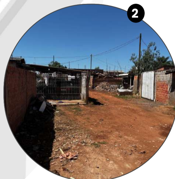
Figura 65: Lote vazio com escombros. Foto: Pela autora, 2024.
